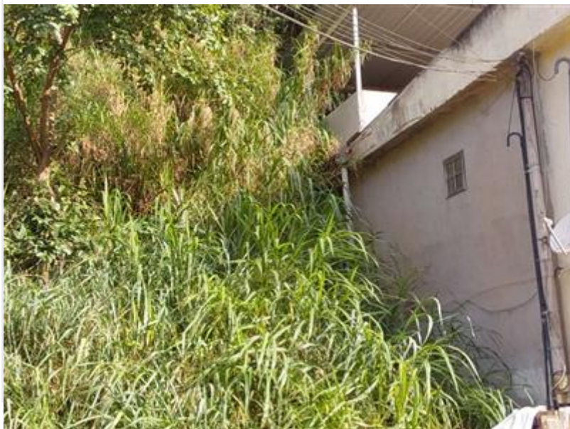
Foto Distância topo do talude - base da casa
