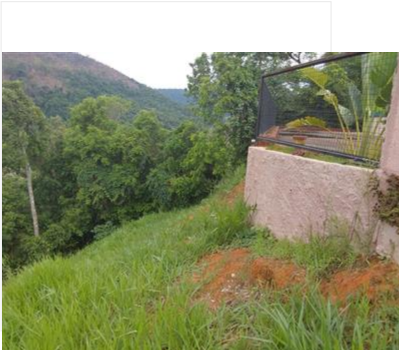
Foto Distância topo do talude - base da casa
