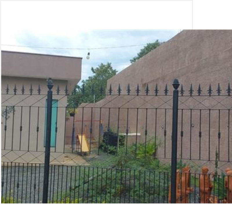
Foto Distância talude – casa
