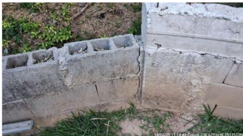
Foto_Trincas_em_muros-20250214-141448.jpg
