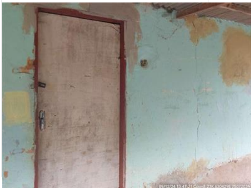
Foto Trincas no terreno
