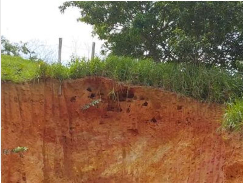
Foto Erosão Laminar
