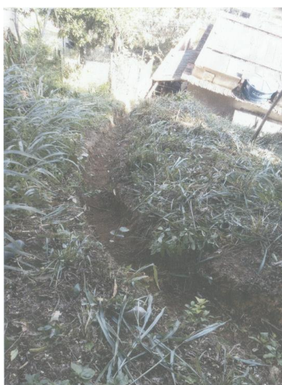
Figura 9 – Valeta de drenagem.
