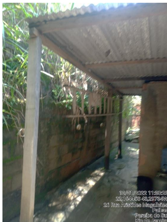
Figura 2 – Muro dos fundos da casa.
