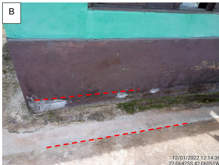
Figura 7 – (A) e (B): Presença de trincas no terreno e na estrutura da residência s/n à montante do talude.
