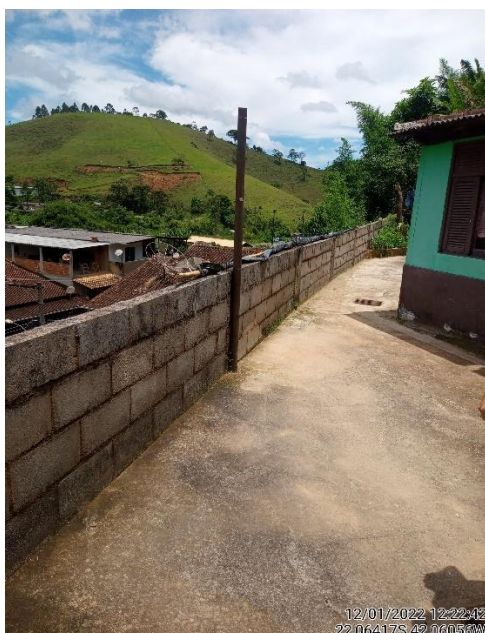
Figura 8 – Muro de alvenaria.
