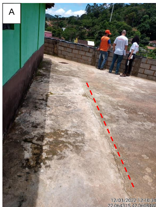
Figura 7 – (A) e (B): Presença de trincas no terreno e na estrutura da residência s/n à montante do talude.
