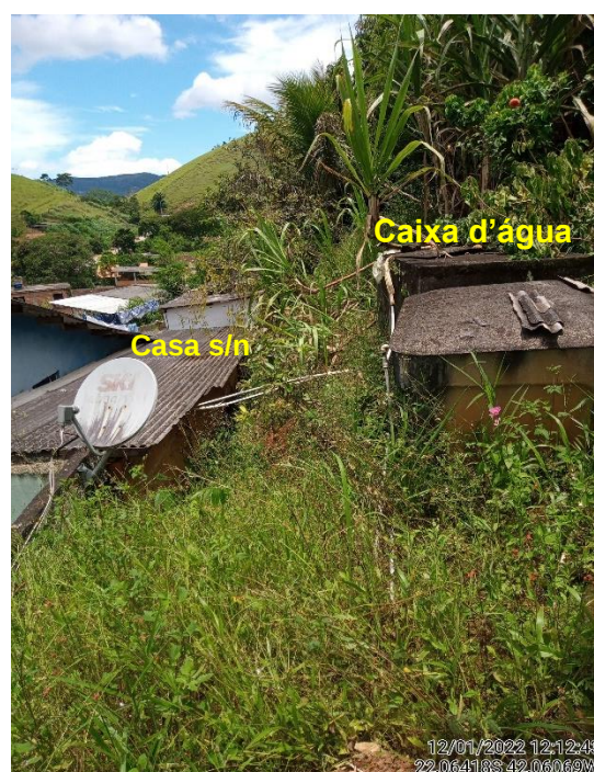
Figura 11 – Talude nos fundos da residência s/n.
