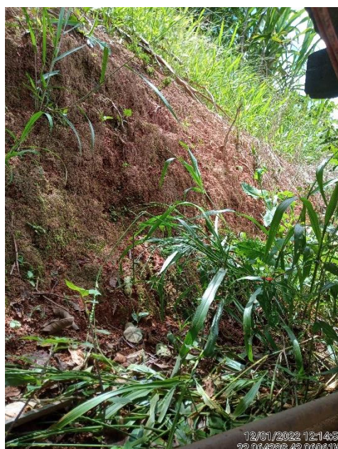
Figura 9 – Vista frontal do talude nos fundos da casa s/n à montante da casa nº 4.
