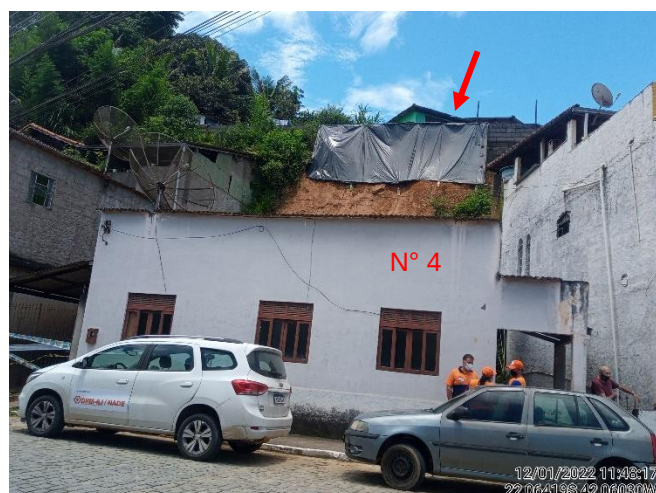
Figura 2 – Foto frontal da residência nº 4.
