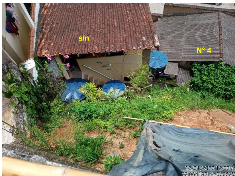
Figura 12 – Residência (s/n) ao lado da casa nº 4 com o talude composto no terreno.
