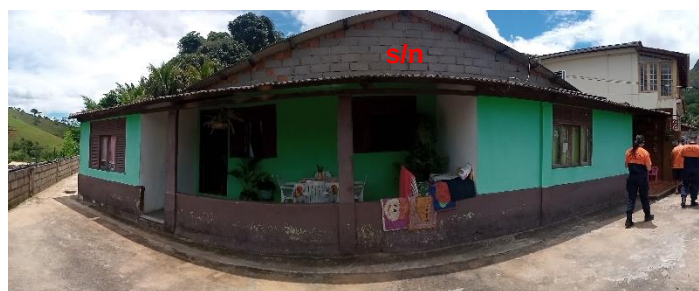
Figura 3 – Foto frontal da residência s/n.
