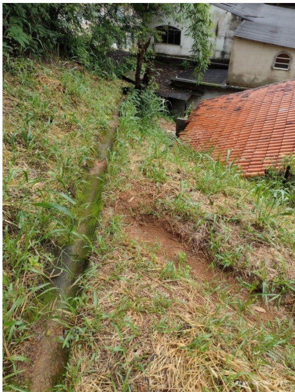
Figura 21: detalhe da canaleta.
