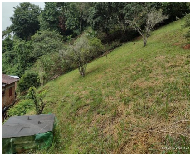
Figura 20: Toda parte superior do talude com gramínea e as canaletas (a de terra próxima à caixa de água) e a de cimento mais acima.
