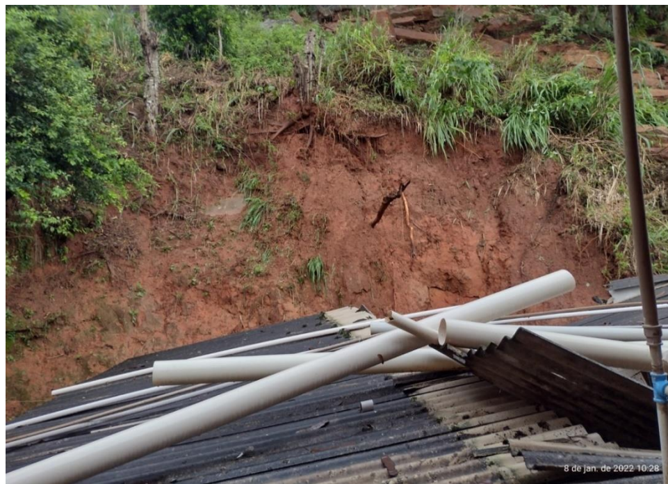
Figura 9: Talude rompido.
