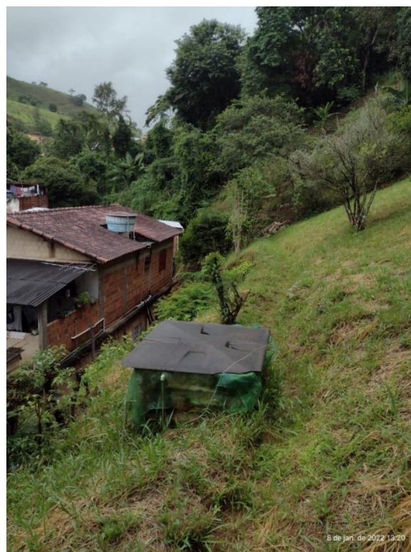
Figura 22: Talude e residência.
