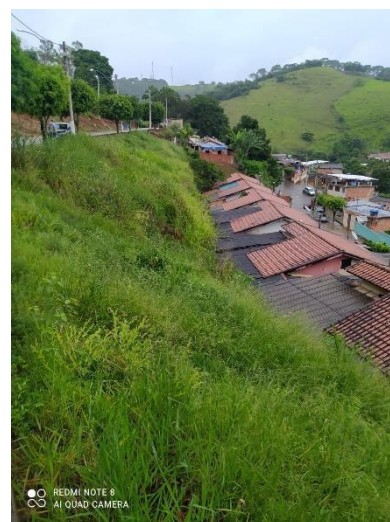
Figura 27: Rua Residencial Bela Vista à montante das residências de números 9 e 12 na Rua Residencial Irene.
