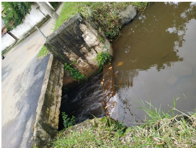
Figura 2: Detalhe da represa
