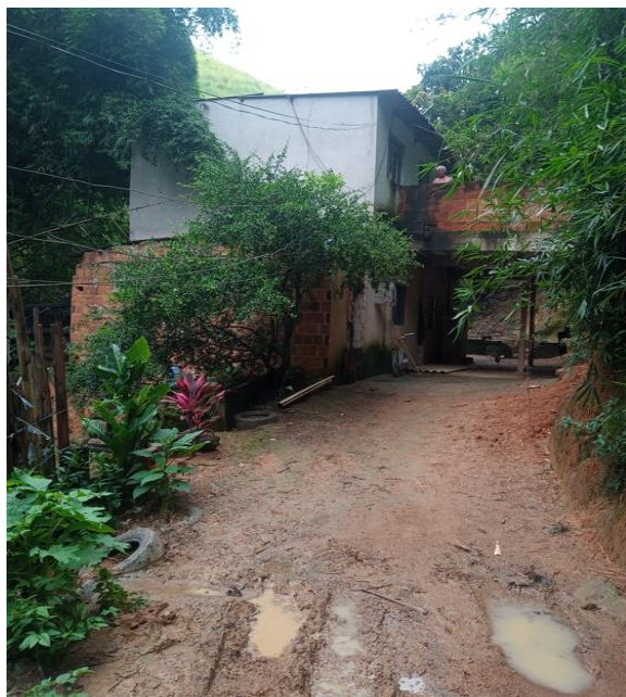
Figura 11: Vista frontal da casa nº 4187.
