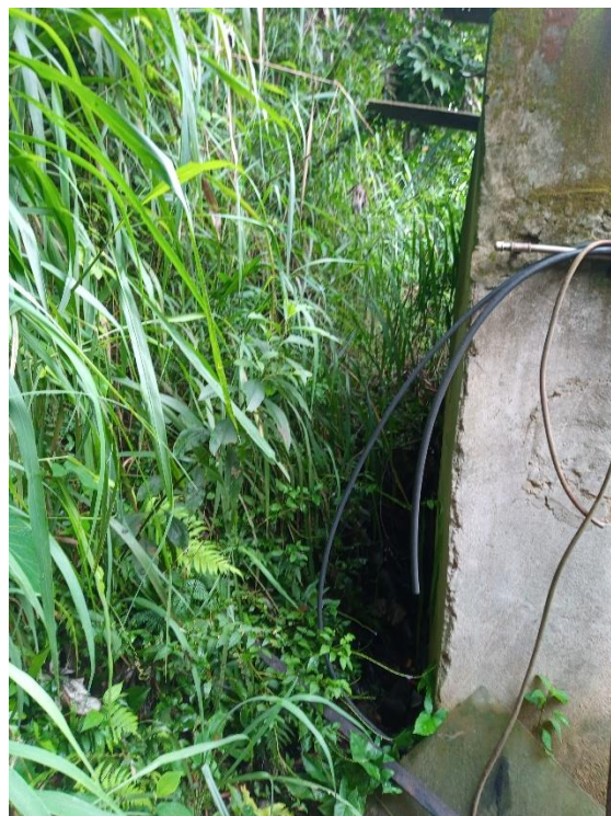
Figura 21: Talude com bastante vegetação próximo a residência de nº 4197.
