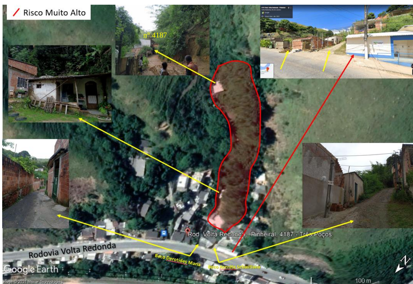
Figura 1: Polígono de Risco das residências na Rodovia Volta Redonda, Bairro Três Poços.
