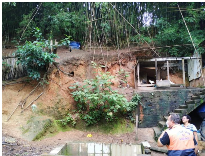
Figura 8: Fundos da residência com escoamento de água à jusante e árvores inclinadas.
