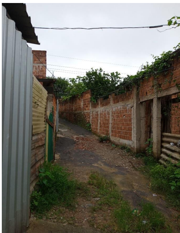
Figura 15: Acesso ao beco Derotides Maria para as 3 residências à jusante da servidão.
