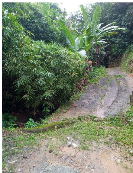
Figura 19: Parte dos fundos do terreno que dá acesso a residência de nº 4187 à montante.
