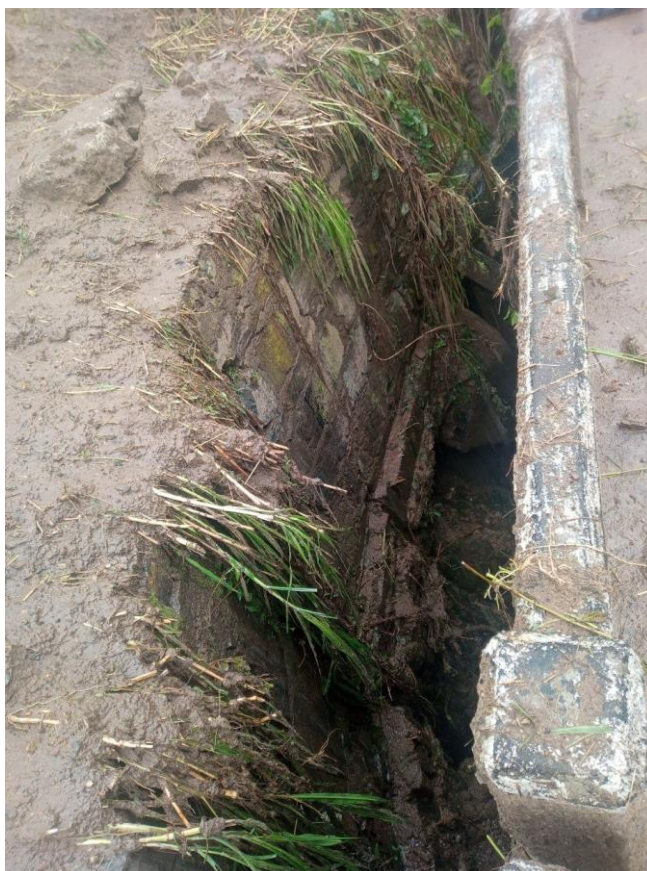
Figura 6: Vala na lateral da rodovia
