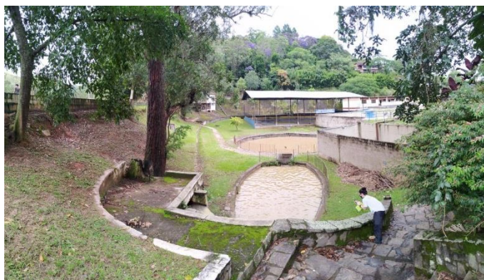
Figura 2: vista geral da ETE
