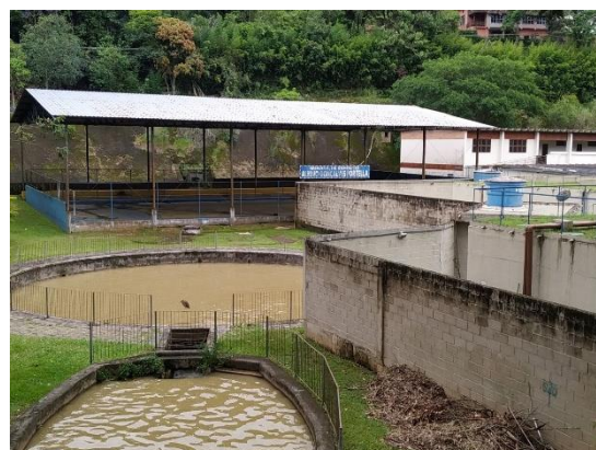
Figura 3: detalhe da quadrada
