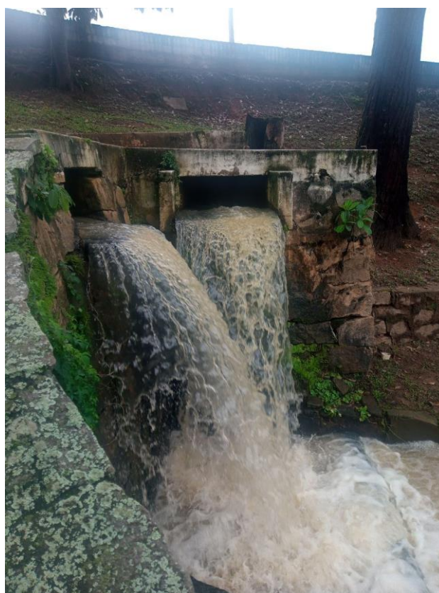
Figura 4: detalhe do duto extravasor
