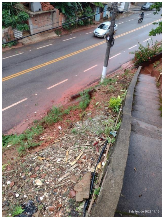
Figura 10: Acesso à casa, e lançamento de material antrópico sobre o residual.
