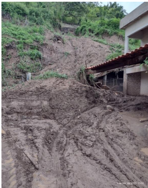
Figura 2: Á montante a rodovia, o talude e o fluxo de detritos.
