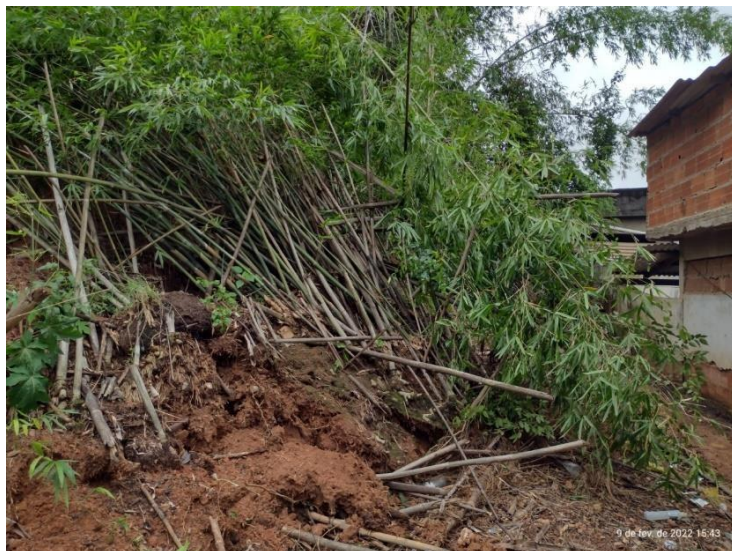
Figura 7: Vista do escorregamento.
