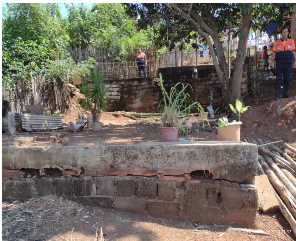
Foto 7 – Local onde foi demolida uma residência.
