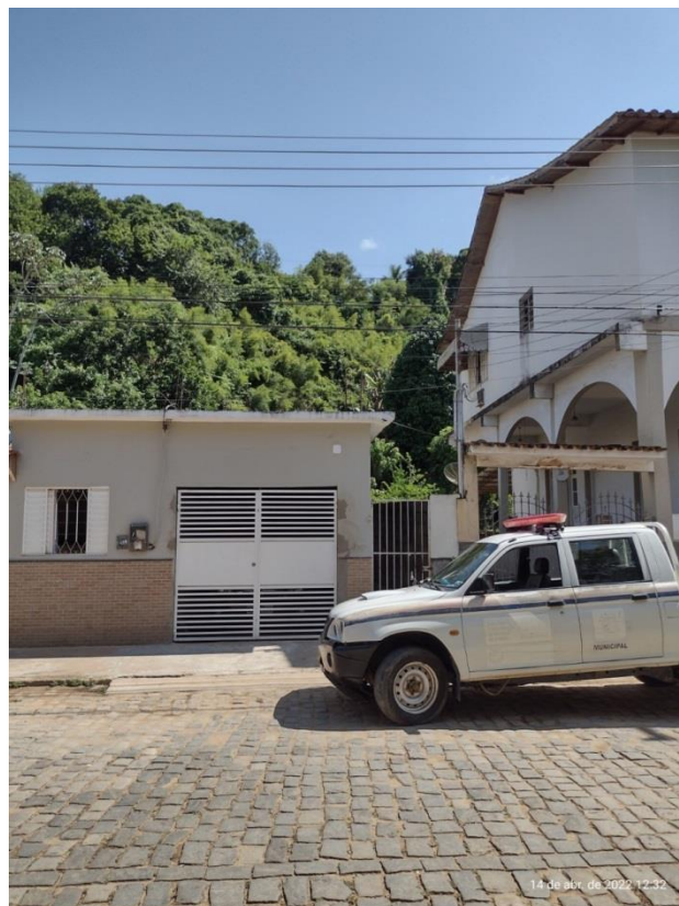
Foto 13 – À montante área já revegetada, onde ocorreu escorregamento em 2010, residência na Rua Alexandre Betrel.
