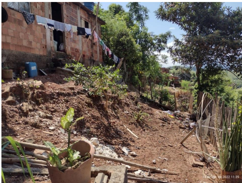
Foto 8 – Residência construída em aterro, sem qual quer tipo de proteção do solo.
