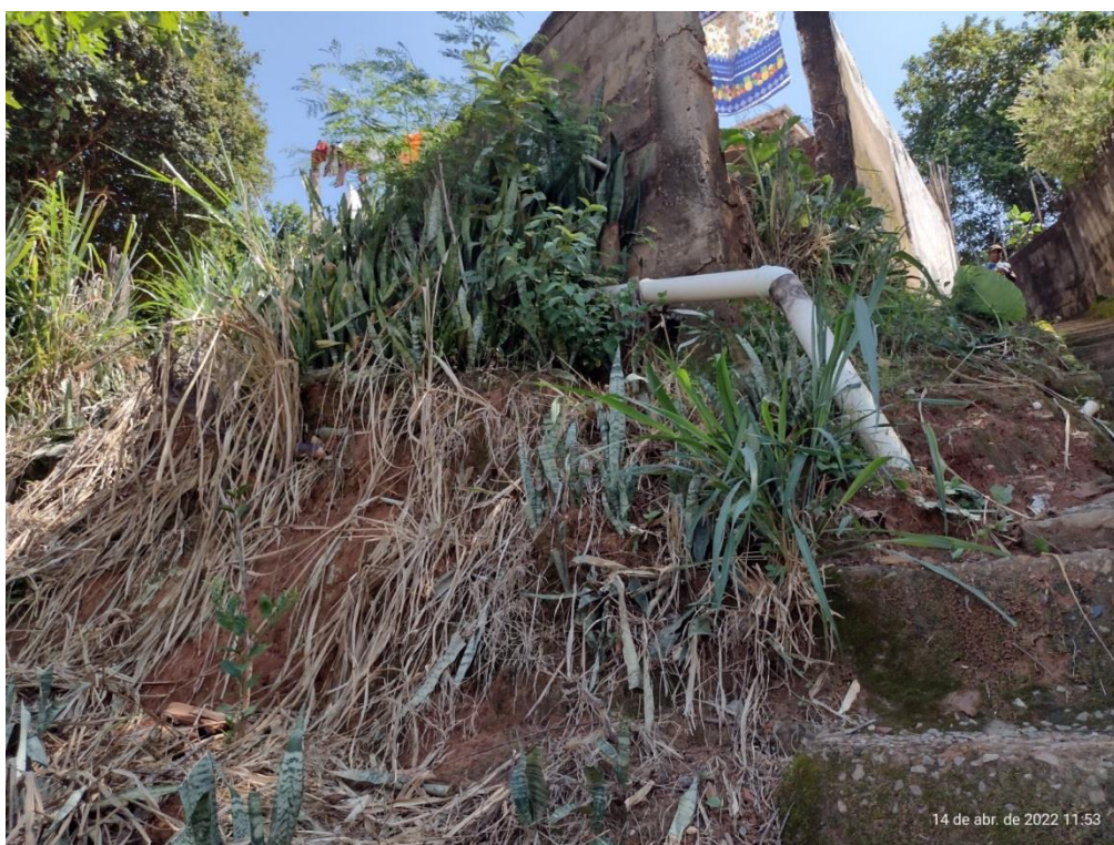
Foto 10- Local onde foi reconstruída uma residência após a demolição.
