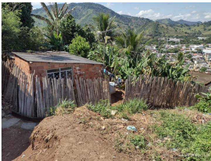
Foto 2- Residência à meia encosta , construída em aterro.
