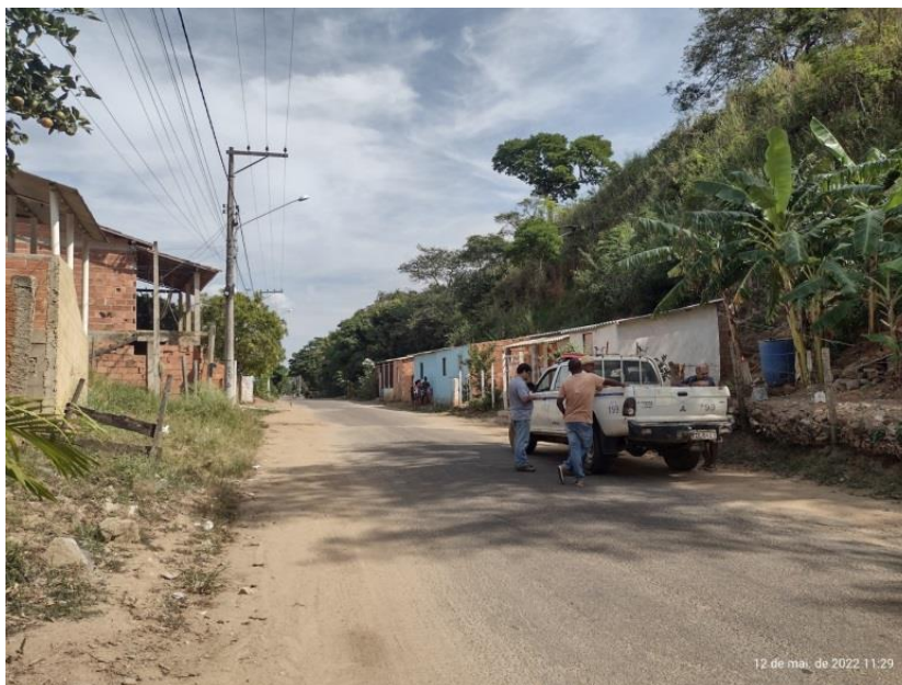
Figura 11- Residências localizadas ao pé da encosta da RJ-204.
