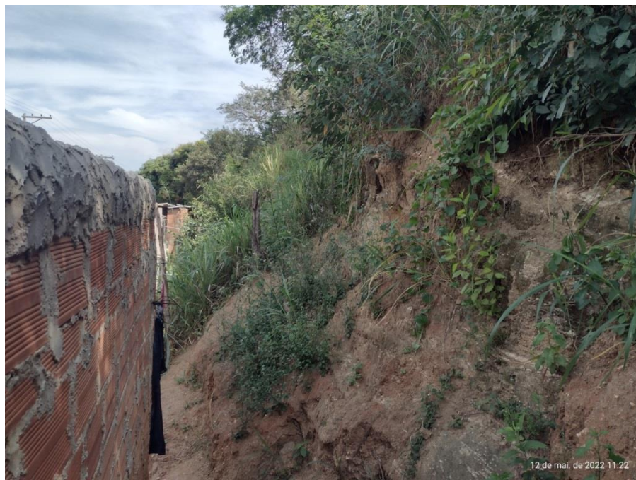
Figura 11- Talude nos fundos de uma das residências.
