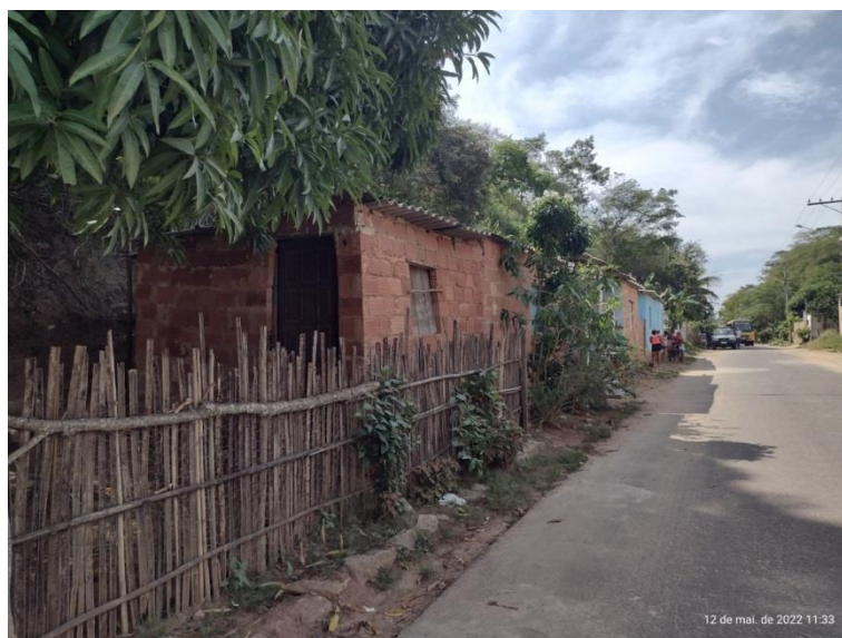
Figura 14 – Vista das outras residências.
