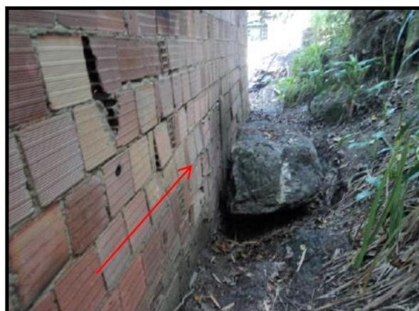
**Figura 3:** Bloco de rocha com volume de apenas 0.6 m<sup>3</sup>, destruiu os fundos da casa 635 da Trav. Mota, no Barro Vermelho.
