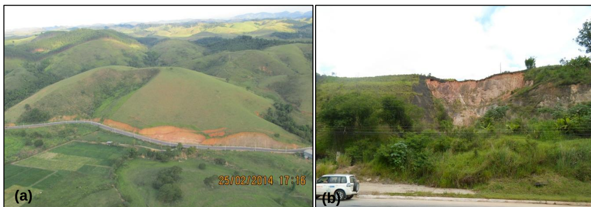
Figura 2: Imagens ilustrativas da unidade solo residual espesso (Unidade SR) localizadas em: (a) Rialto (coordenadas X576607, Y7505895) e (b) São Judas (coordenadas X588395, Y7507677).
