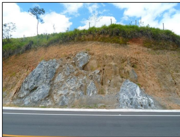
Figura 3: Unidade solo residual raso, dispostos sobre rocha (Unidade S/R) localizadas em Rialto (coordenadas X575871, Y7503677).
