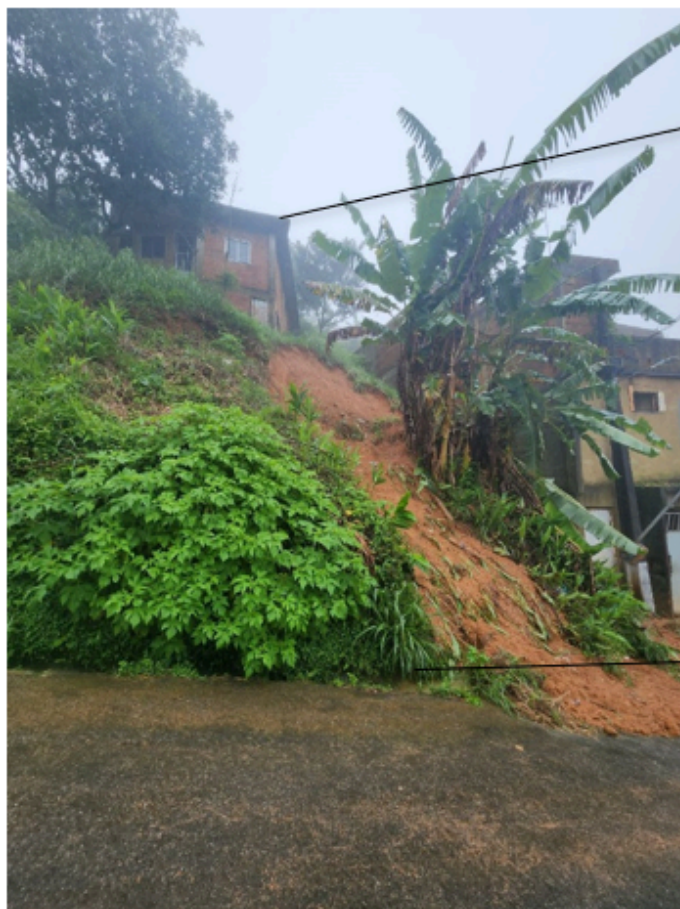
Figura 02: Vista frontal de cicatriz de deslizamento à montante da via, sob a qual há edificação com base apresentando evidente perda de material. Imagem em detalhe da visada do deslizamento a partir da perspectiva à jusante da via.
