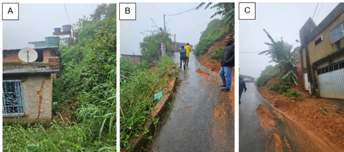
Figura 01: A) Área à jusante da via pública com material oriundo do deslizamento à montante desta depositado aos fundos do imóvel; B) Via pública com parte do material mobilizado às suas margens e, ainda resquícios no centro da via; C) Cicatriz do deslizamento à montante da via, evidenciando grande quantidade de material mobilizado no local.
