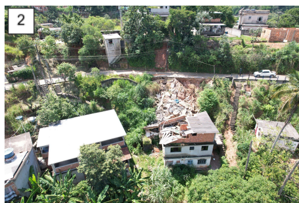
Figura 2: Imagem referente ao ponto e), destacando residência atingida em colapso da via.
