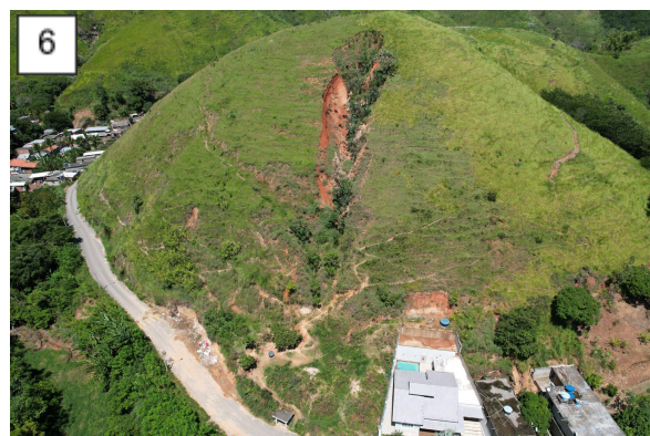
Figura 6: Voçoroca observada ao fim da Rua Benedito Silva Lomba, indicando processo erosivo ativo na área.
