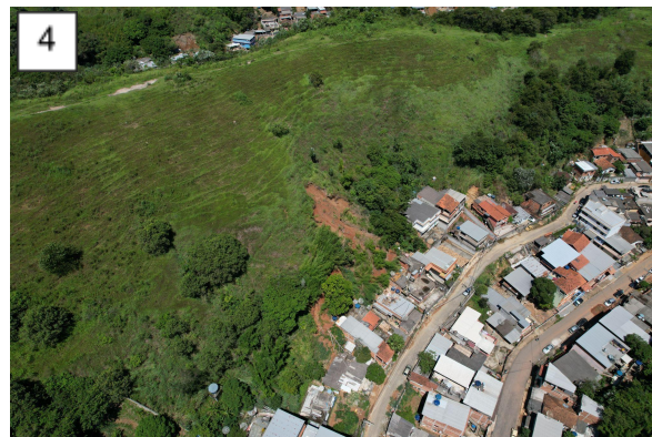
Figura 4: Edificações localizadas diretamente abaixo da cicatriz.
