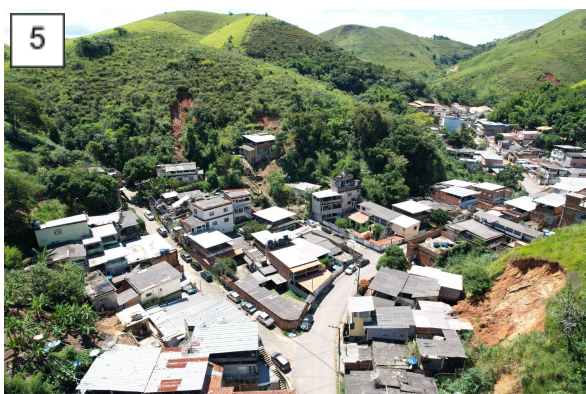
Figura 5: Vista do cenário local, com encostas repletas de cicatrizes e densamente habitadas.
