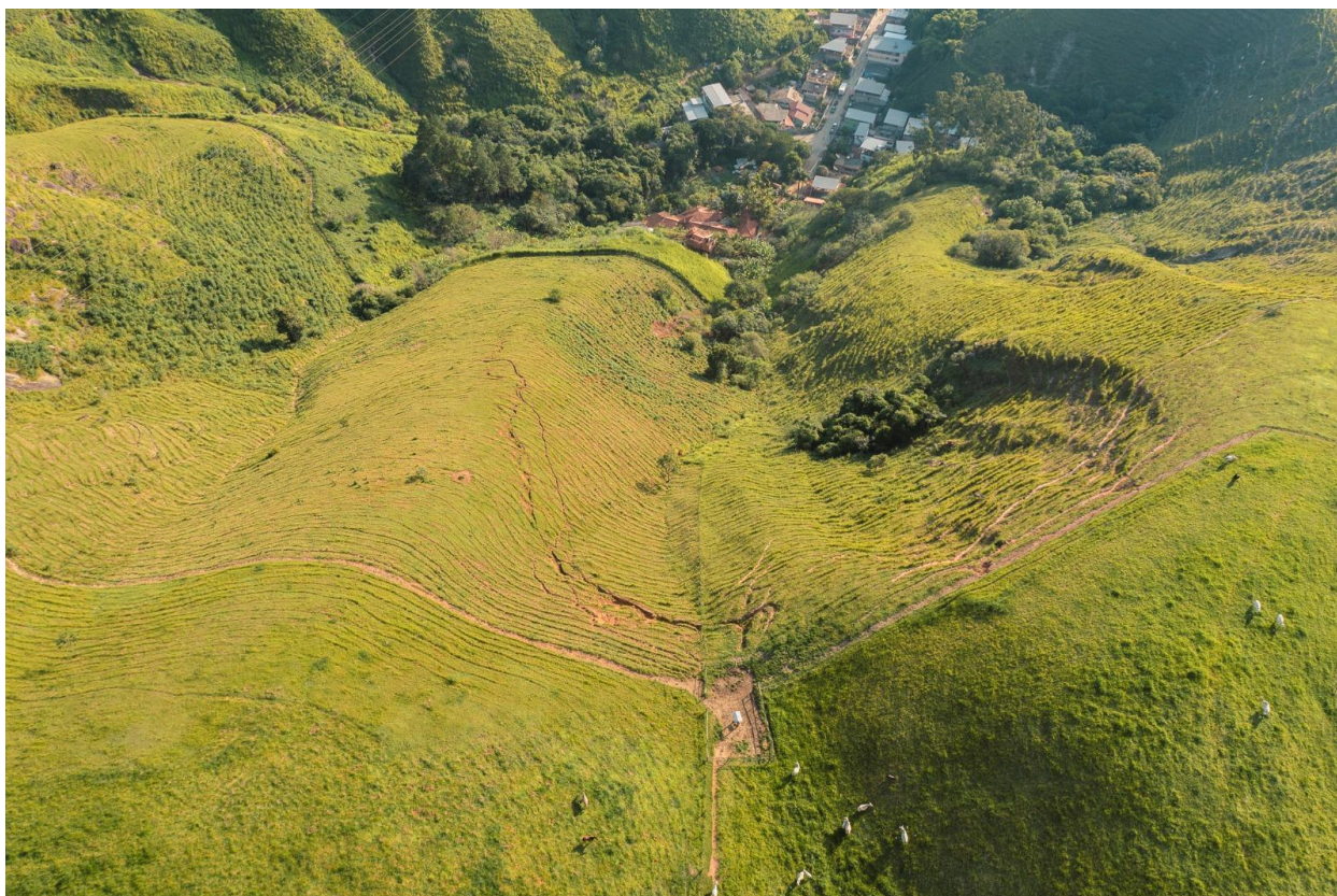
Figura 7: Visada das trincas em direção à Avenida Vera Cruz, ao fundo, descrito em i), através de imagem de drone. É possível ver a origem das trincas da cicatriz próximo ao topo do morrote, no centro da figura, imediatamente abaixo de um objeto branco semelhante à uma caixa d'água. É possível ver ainda uma cicatriz no terço médio da encosta a montante de uma via de acesso, conforme representado no mapa da figura 8.
