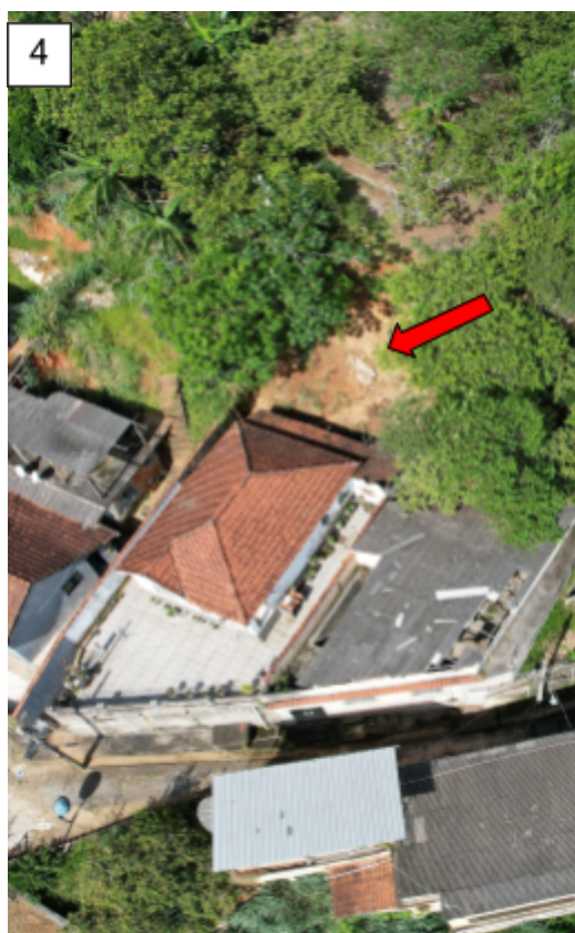
Figura 4: Deslizamento na servidão acima da rua Ovídio de Melo, nos fundos de um imóvel. Cicatriz identificada pelas imagens de drone, descrita em d).
