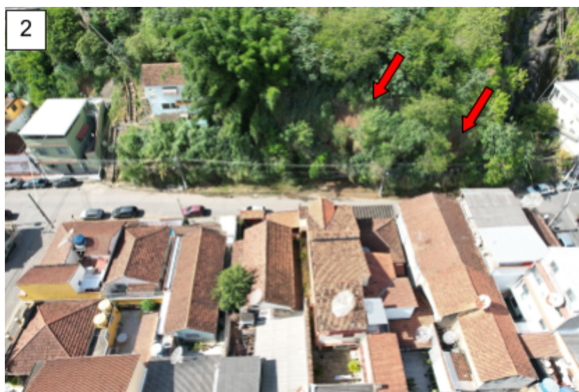
Figura 2: Duas cicatrizes de deslizamento de solo raso sobre rocha na rua Ovídio de Melo, na altura do nº 103. Essas ocorrências estão descritas em b).
