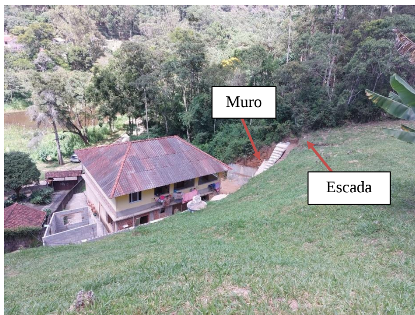
Figura 27 – Encosta nos fundos da residência nº 355.
