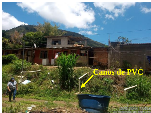
Figuras 20 e 21 – Talude de corte com sistema de drenagem precária.
