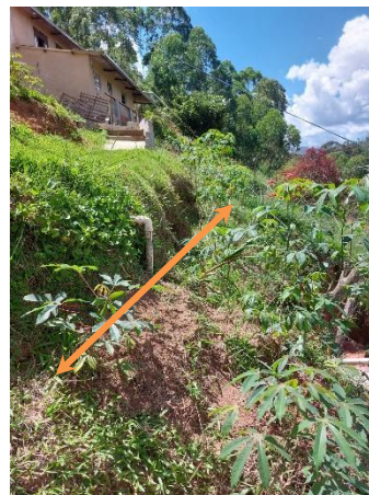
Figuras 28 e 29 – Talude de corte com degrau de abatimento na crista.
