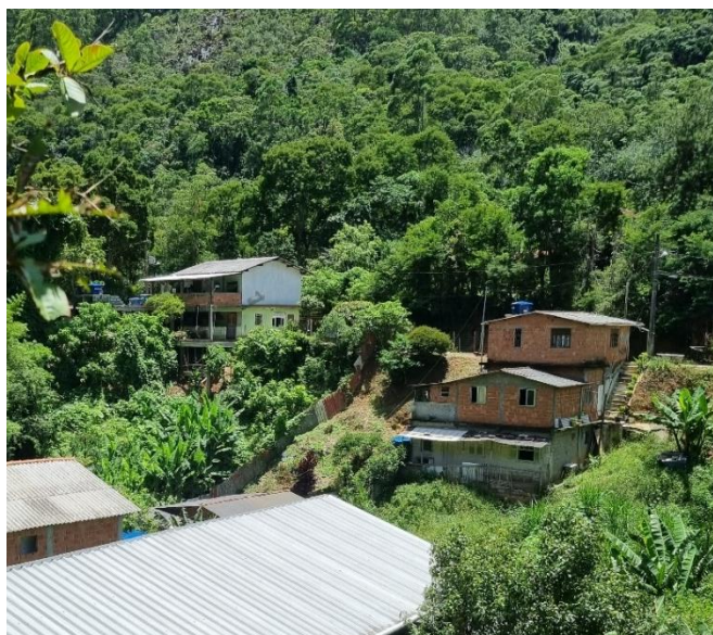
Figura 39 - Moradias em risco alto (R3).
