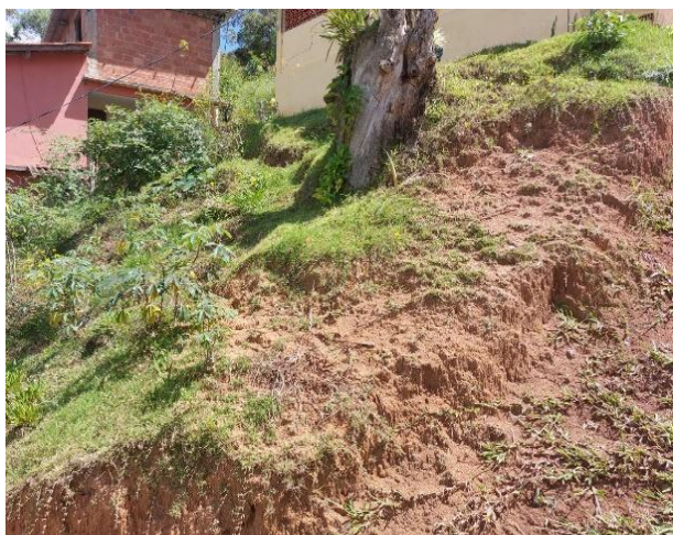
Figura 30 e 31 – Ocorrência de erosão potencializado pela ausência de sistema de drenagem pluvial adequado.
