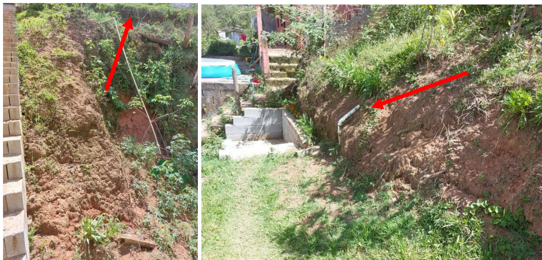
Figuras 32 e 33 – Tubos de PVC ao longo do talude direcionando a água ao sopé.
