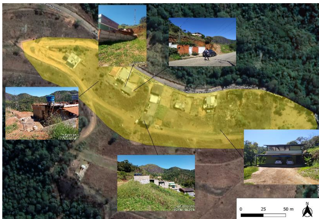
Figura 77 - Taludes de corte presentes na área. Polígono de risco da área 23.
