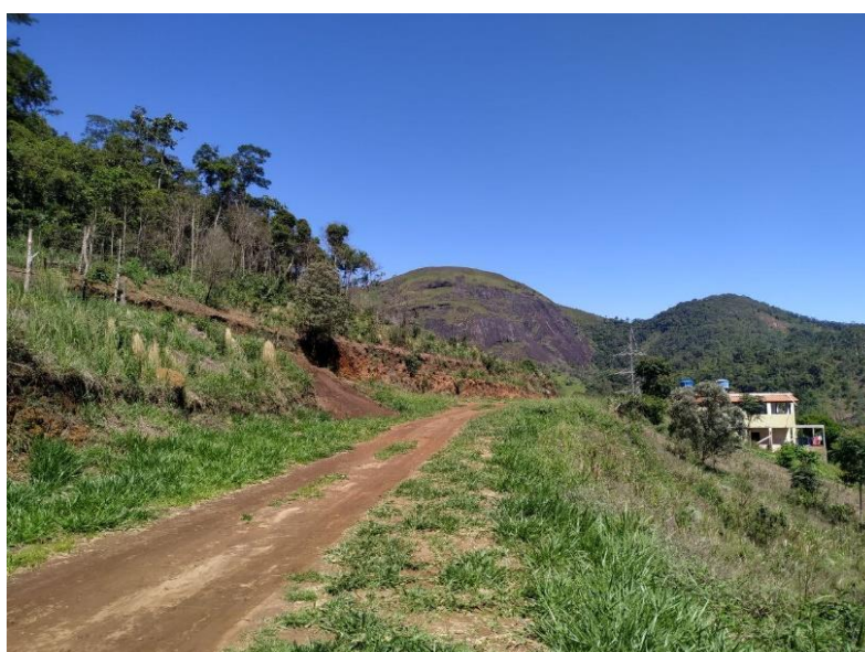
Figura 78 - Rua a montante seguindo do topo da encosta natural.
