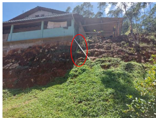
Figuras 71 e 72 - Canos de PVC potencializando o escoamento superficial de águas pluviais.
