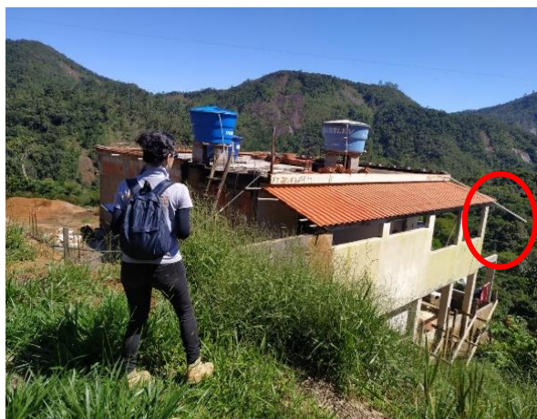
Figuras 79 e 80 – Canos de PVC potencializando o escoamento superficial de águas pluviais.
