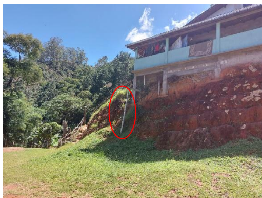
Figuras 71 e 72 - Canos de PVC potencializando o escoamento superficial de águas pluviais.
