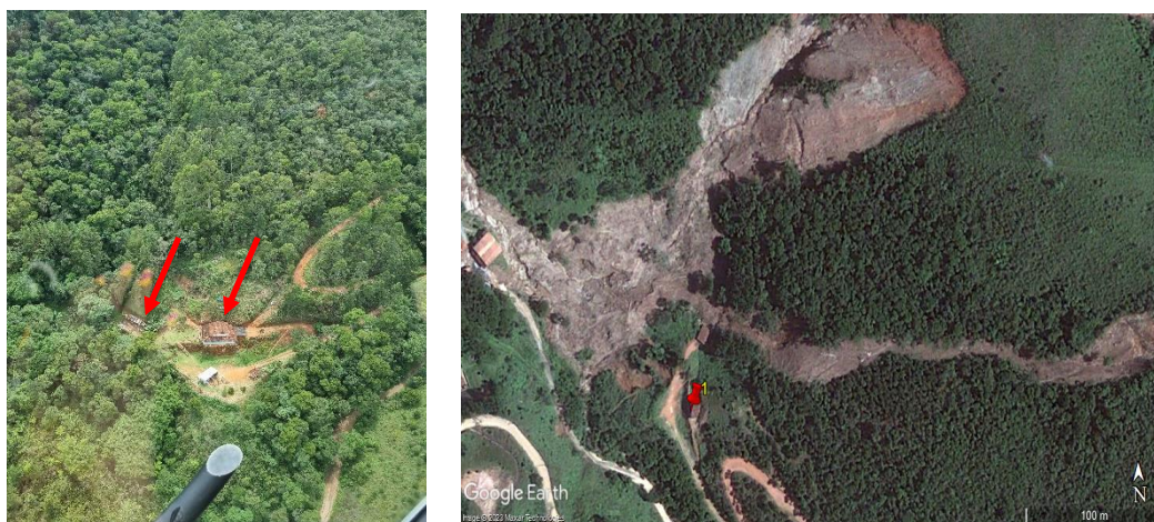
Figura 66 e 67 – Talude de corte nos fundos da residência (setas) e proximidade com escorregamentos ocorridos em janeiro de 2011.
