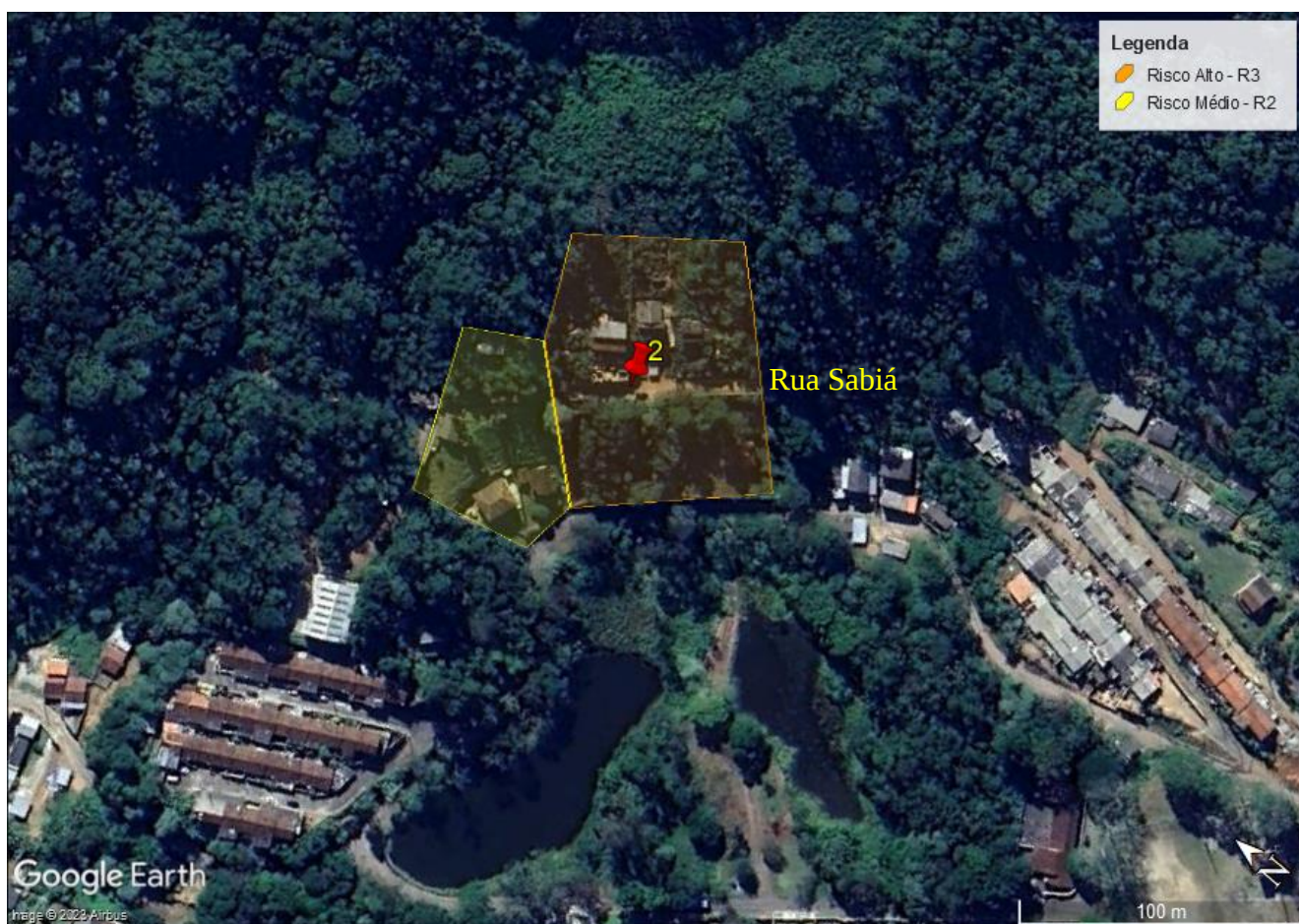
Figura 37 – Polígonos de risco da área 12.
