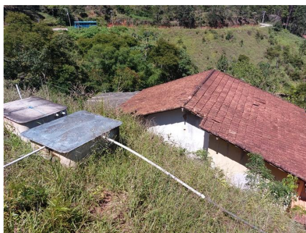
Figura 70 - Caixas d'água na crista do talude.
