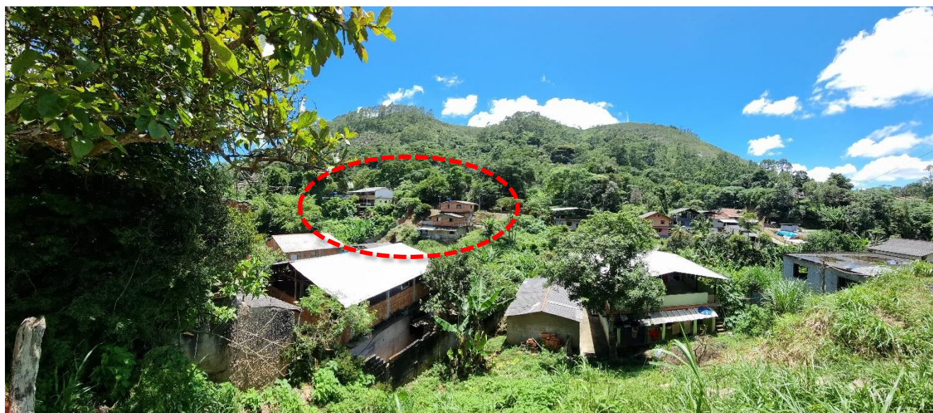
Figura 38 - Visada panorâmica do polígono 15 (residências ao fundo da imagem), com destaque para as moradias em risco alto (R3).
