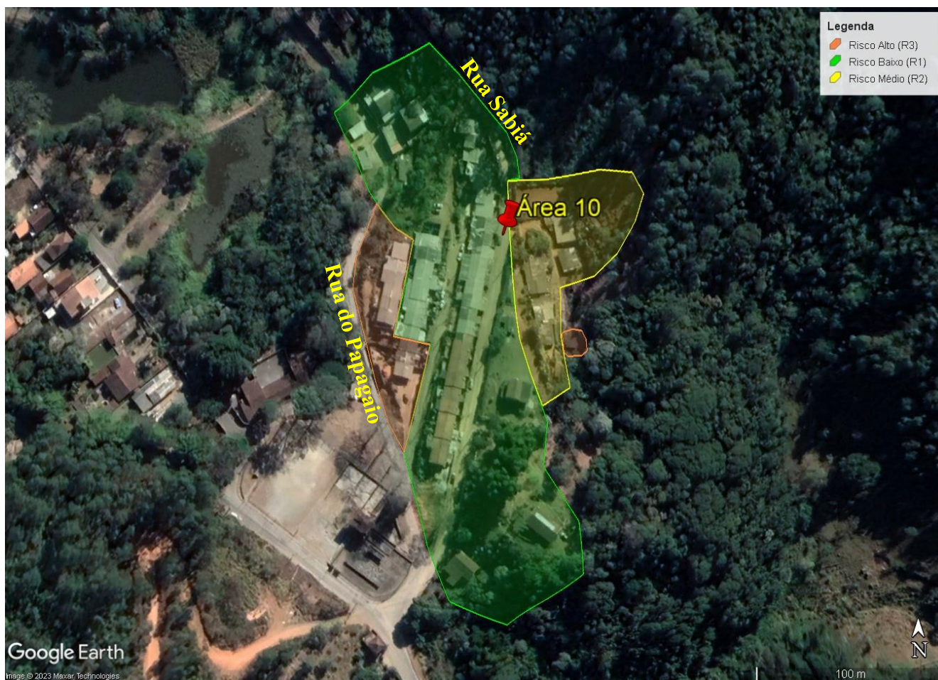
Figura 26 – Polígonos de Risco Alto, Médio e Baixo – Ruas Sabiá e do Papagaio, Bairro Granja Spinelli.
