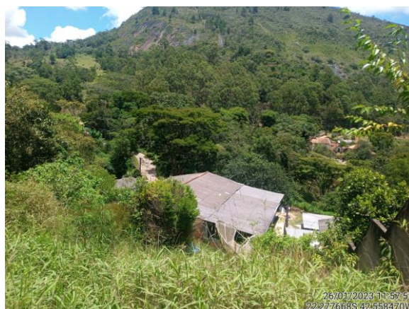
Figura 25 - D – Residência a jusante da rua Sabiá sem sistema de drenagem.
