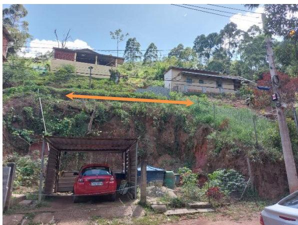
Figuras 28 e 29 – Talude de corte com degrau de abatimento na crista.
