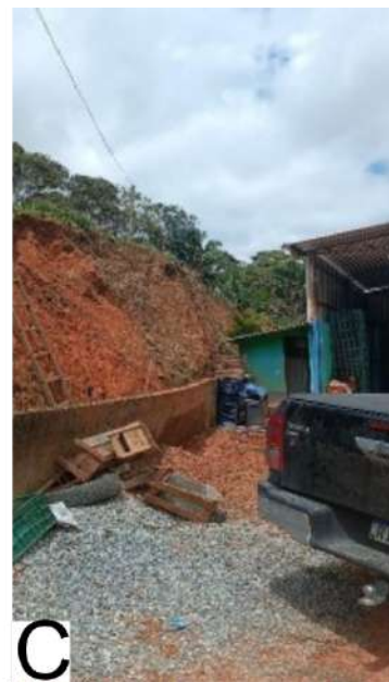
Figura 18 - A - Fundo do Vale. B - Açude na base da encosta. C - Talude de corte com deslizamento.
