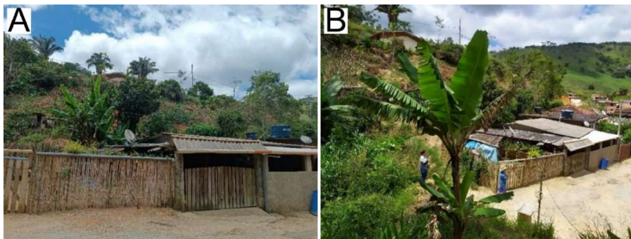
Figura 23: A e B - Casas próximas a encosta na vertente do lado direito da rua.
