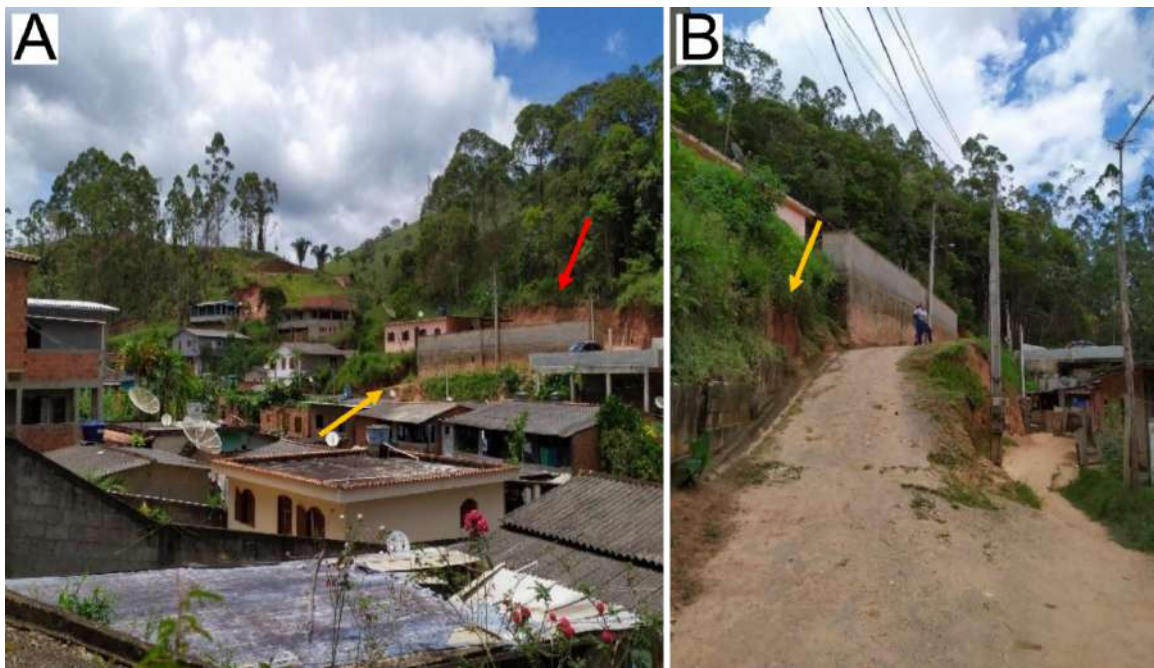
Figura 32: A - Indícios de deslizamentos a montante e a jusante da construção; B - Muro a jusante da construção, com drenagem insuficiente e indícios de novos deslizamentos no corte.
