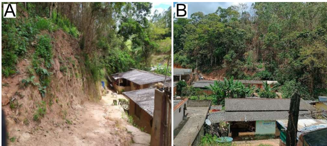
Figura 34: A e B - Casas vulneráveis próximas a encosta.
