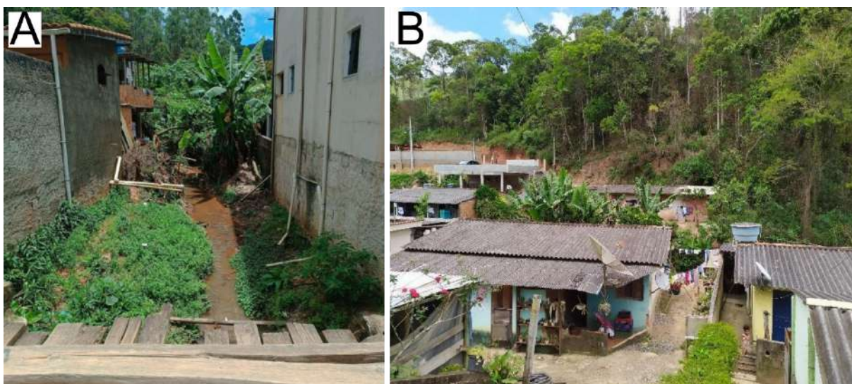
Figura 29: A – Córrego que corta as casas, que estão construídas bem próximas a margem; B – Indicação das casas cortadas por drenagem
