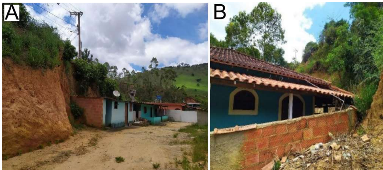
Figura 27: A e B Construções próximas a encosta e com sinais de deslizamentos.
