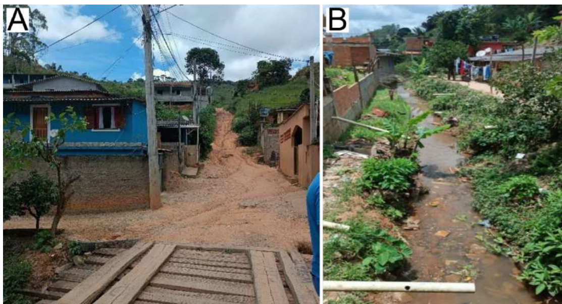
Figura 31: A - Ponte de madeira sobre o córrego; B – Canos de esgoto ligados diretamente ao córrego
