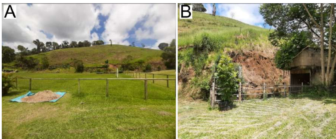
Figura 10: A – Ponto no campo de futebol. B – Vestiário próximo ao talude.
