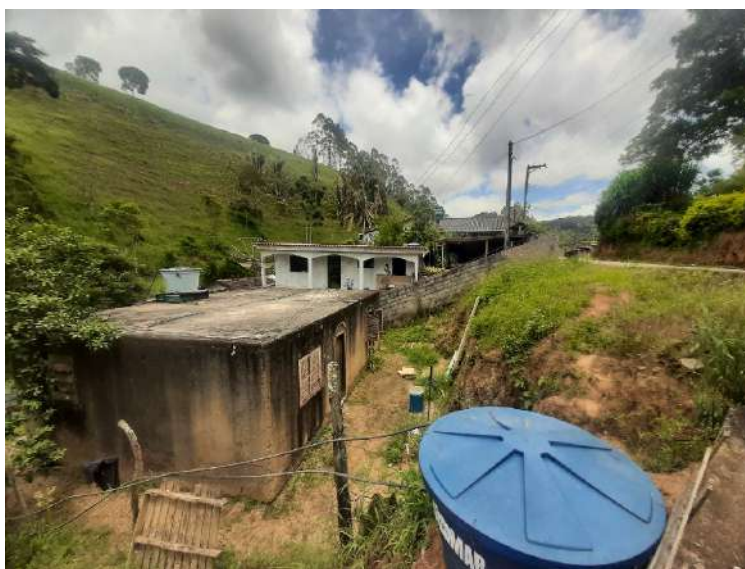
Figura 14: Residência construída próxima ao talude de corte.
