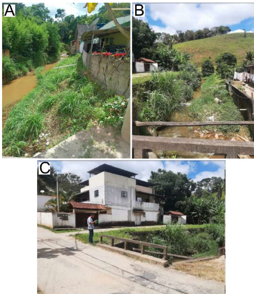
Figura 9: A – Córrego que corta o Morro Agudo com residências localizadas na margem. B – Despejo de esgoto direto no córrego. C – Ponte sobre o Rio do Capim.
