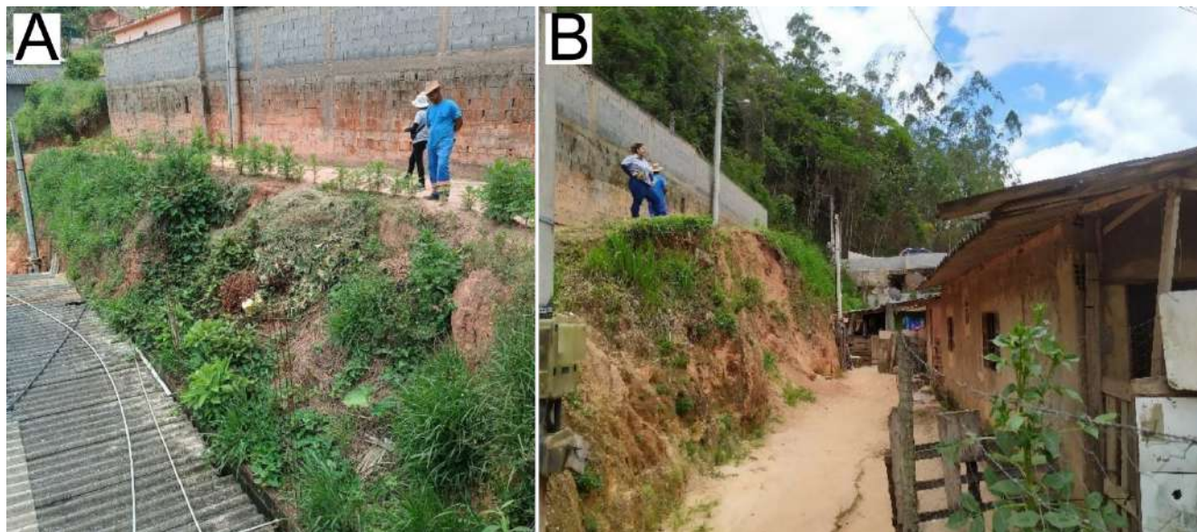
Figura 35: A - Construções próximas as encostas B – Encosta baixa e distante da construção
