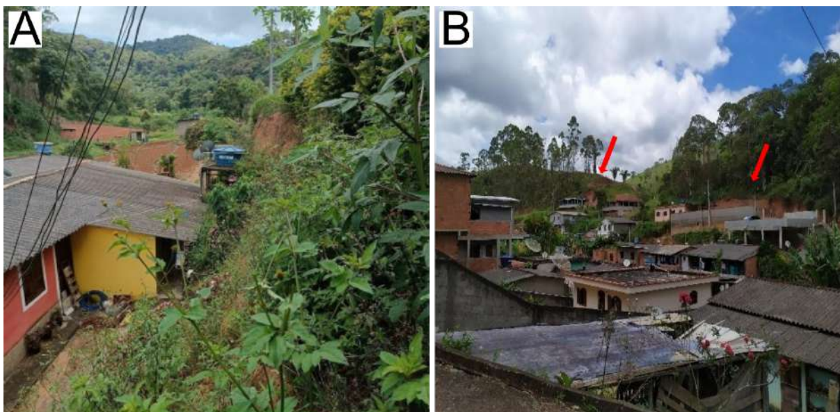
Figura 28: A - Construções próximas a encosta e dentro do vale. B – Cicatrizes de deslizamento.
