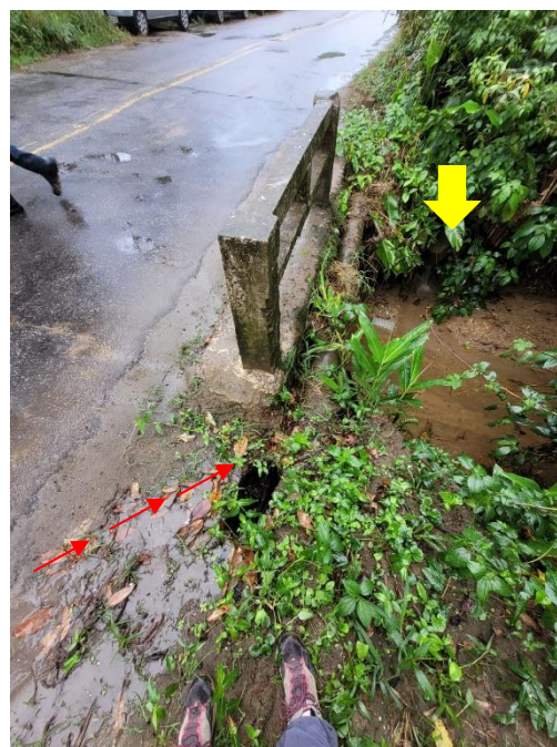
Foto 4: Detalhe do escoamento da pista (seta vermelha) e desague da manilha da via (seta amarela).
