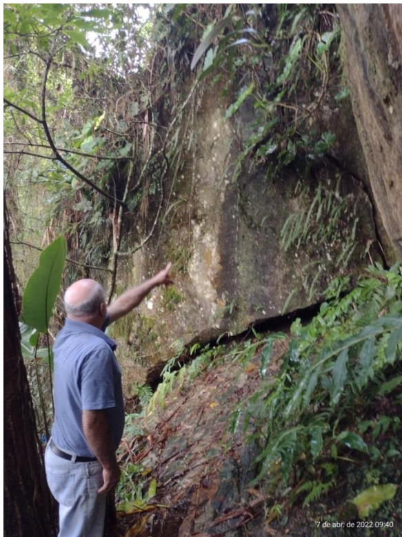
Figura 8- Bloco que foi fraturado pelo raio em 1988, o eixo maior está direcionado para jusante.
