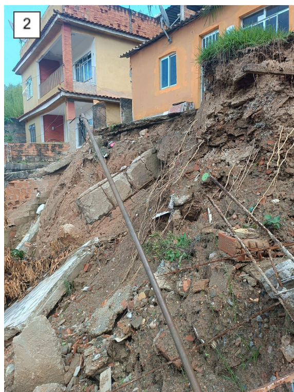
Figura 01: Deslizamento que provocou a queda de um muro e o acesso às residências.
