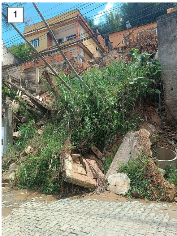
Figura 01: Deslizamento que provocou a queda de um muro e o acesso às residências.
