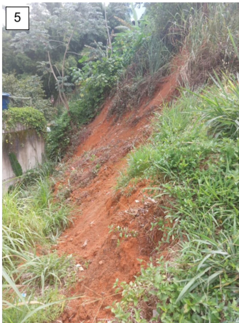
Figura 05: Deslizamento junto à servidão impactando sobre o telhado de um galpão.
