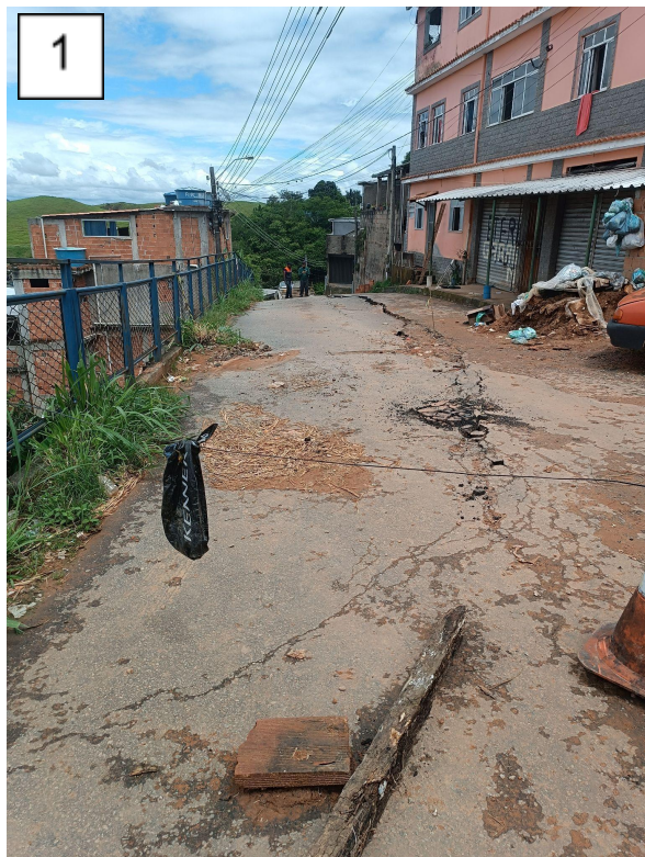
Figuras 1 e 2: Trinca na rua Luiz Camerano.
