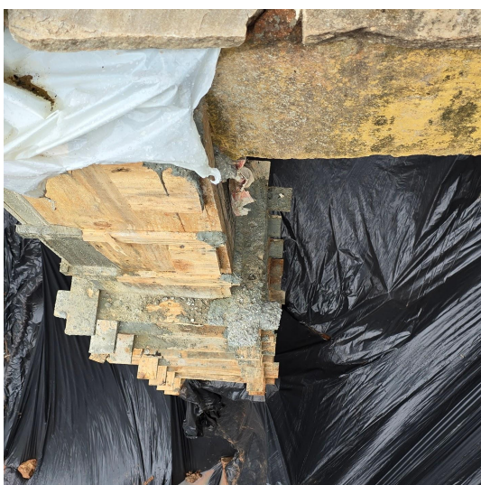
Figura 05: Pilar estrutural, construído junto ao ponto de ruptura do deslizamento em manutenção.
