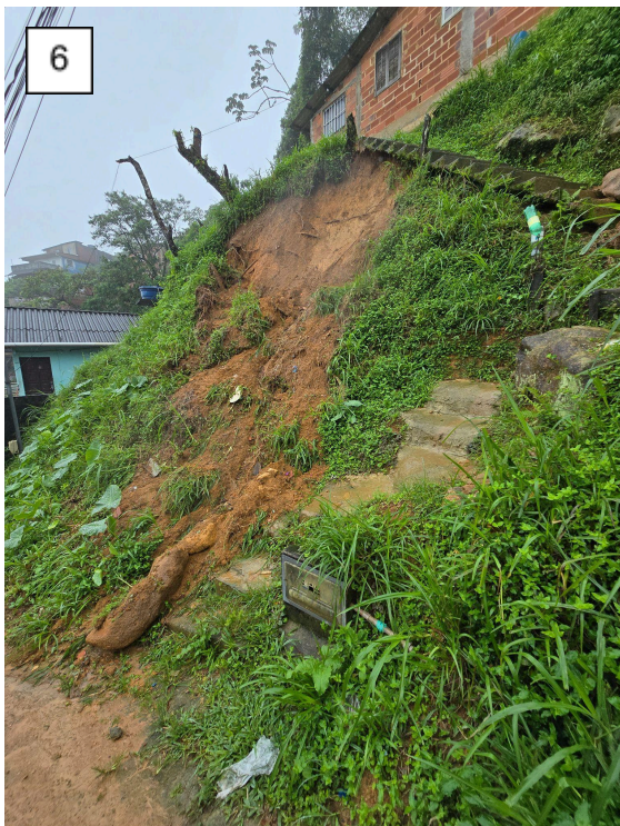
Figuras 6 e 7: Cicatrizes de deslizamentos planares ao longo da encosta situada entre a Rua Glauce Rocha e Rua Antonio Silva Ligeiro.
