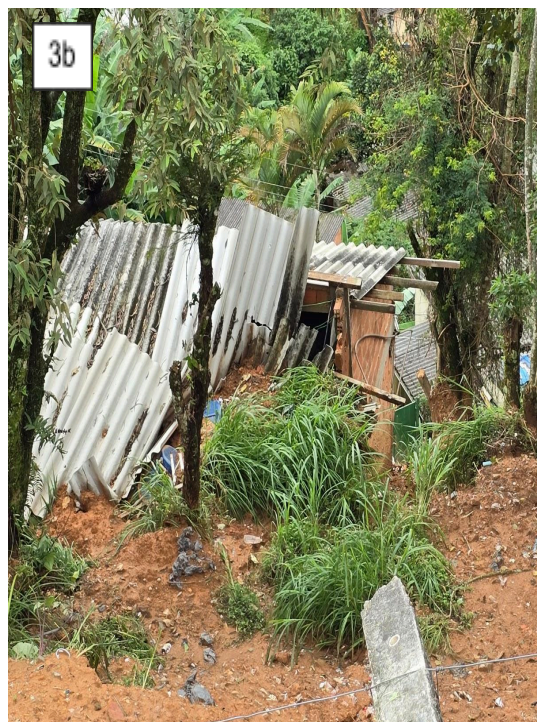
Figuras 3: a) Deslizamento planar com atingimento de fundo do imóvel vista de montante para jusante; b) Detalhe para o atingimento do imóvel.
