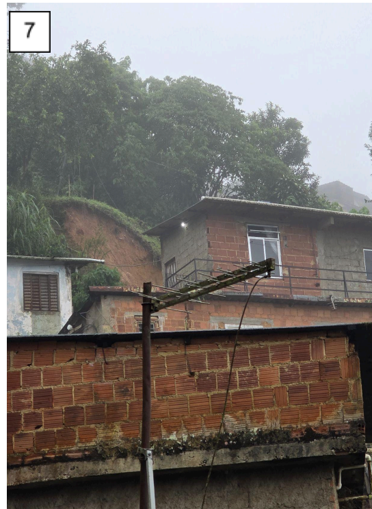
Figuras 6 e 7: Cicatrizes de deslizamentos planares ao longo da encosta situada entre a Rua Glauce Rocha e Rua Antonio Silva Ligeiro.
