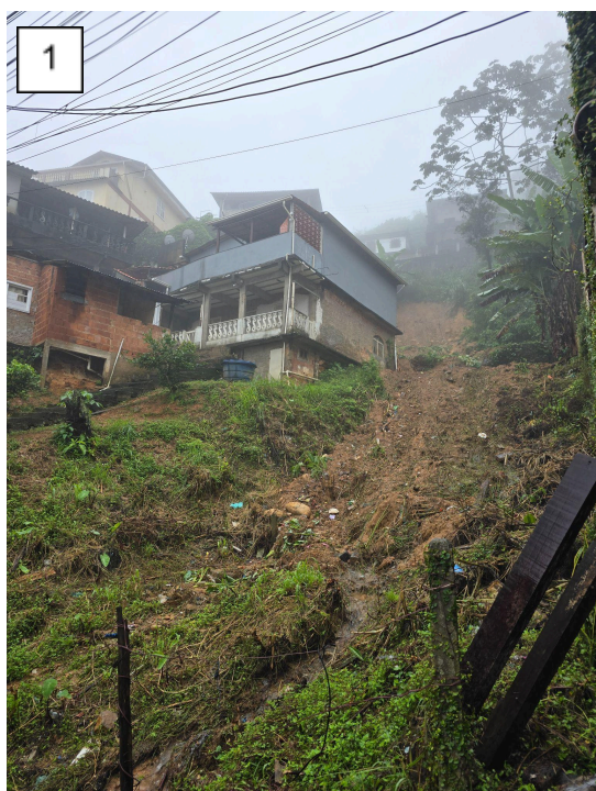
Figuras 1 e 2: Deslizamento planar que atingiu o fundo do imóvel localizado na Rua São Jerônimo, 1114.
