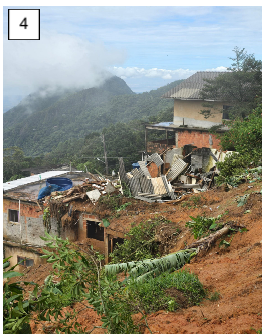
Figuras 4 e 5: Detalhe para alguns dos atingimentos e suas consequências - em 3, desabamento total de uma edificação e, em 4, desabamento parcial de edificação identificada como nº 2670.
