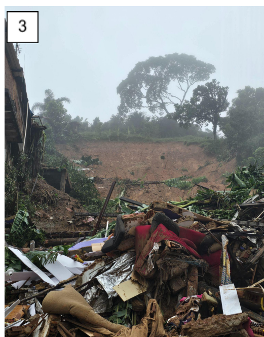
Figuras 2 e 3: Deslizamento planar com desabamento de três edificações.
