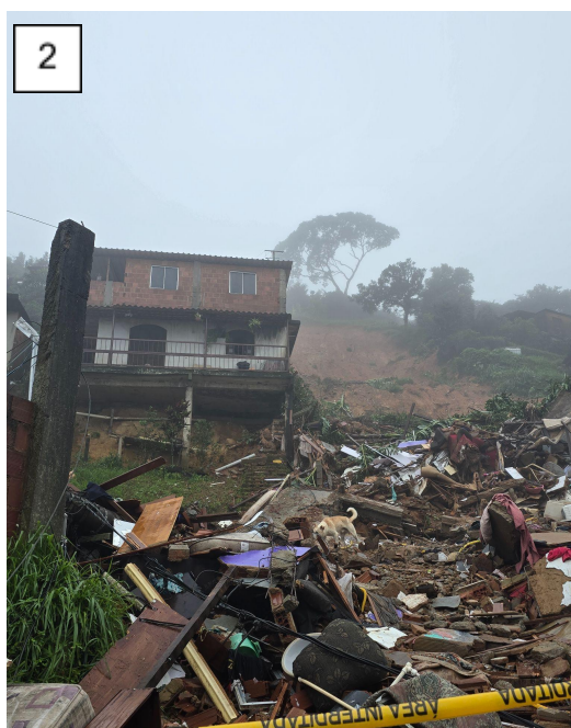
Figuras 2 e 3: Deslizamento planar com desabamento de três edificações.
