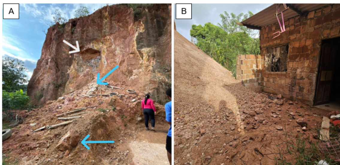
Figura 1. (A) Vista do evento, a seta branca indica local onde se desprenderam blocos, setas azuis indicam blocos; (B) Material mobilizado na lateral da casa, o alcance foi até a porta, porém muito já foi removido por moradores.
