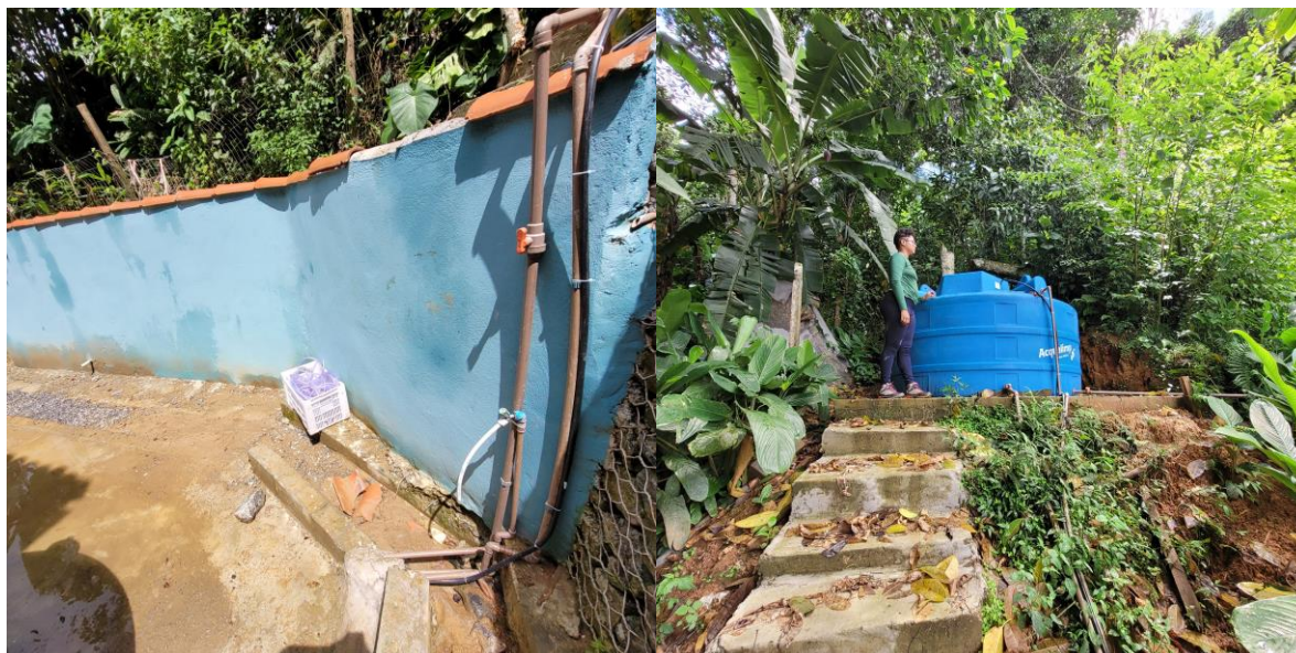
Figura (8) Muro de alvenaria em continuidade à porção oeste do muro de arrimo; (9) escada de alvenaria a montante do muro com patamar com alocação de caixa d'água.
