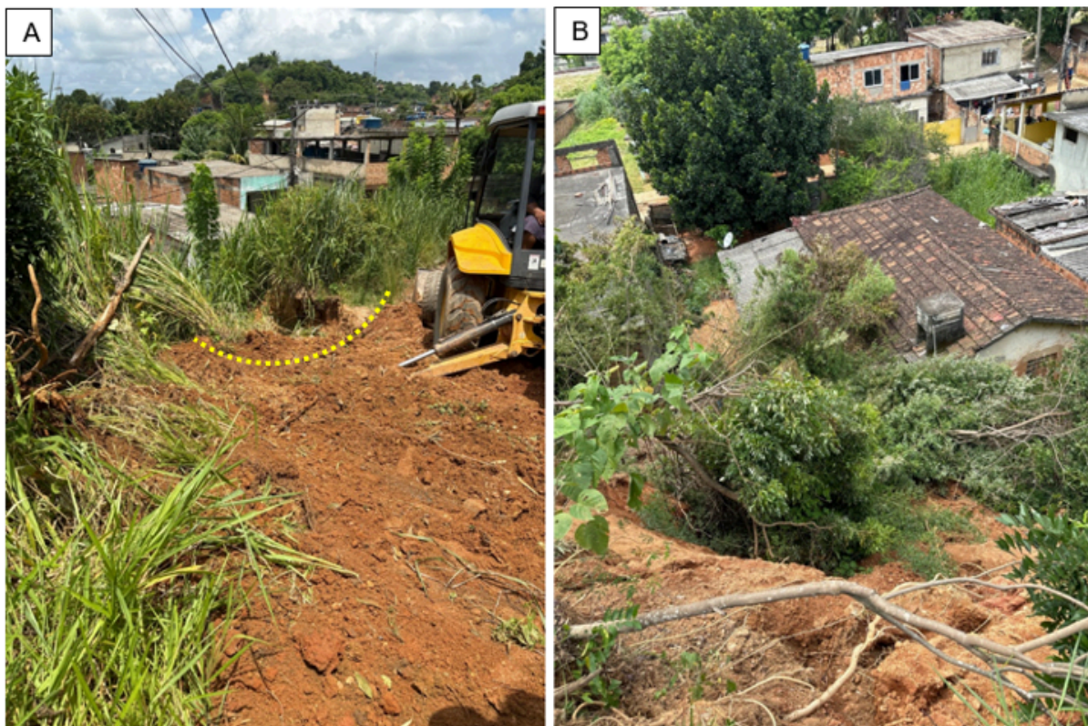
Figura 02: A) Crista da cicatriz de deslizamento ao qual retroescavadeira está ao lado, favorecendo a mobilização de material instável; B) Imóveis da Rua Alcântara atingidos por solo e vegetação resultantes do deslizamento ocorrido à jusante da Rua do Farol.
