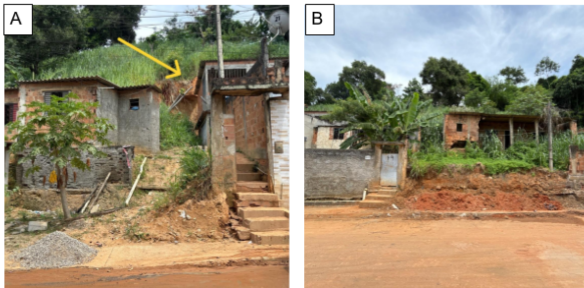
Figura 4. (A) Seta amarela aponta cicatriz aos fundos do imóvel identificado com nº 6. (B) Segundo imagens de drone, o evento atingiu até o nº 79, porém o imóvel sem número à direita possui um processo erosivo ativo na porção frontal da construção.
