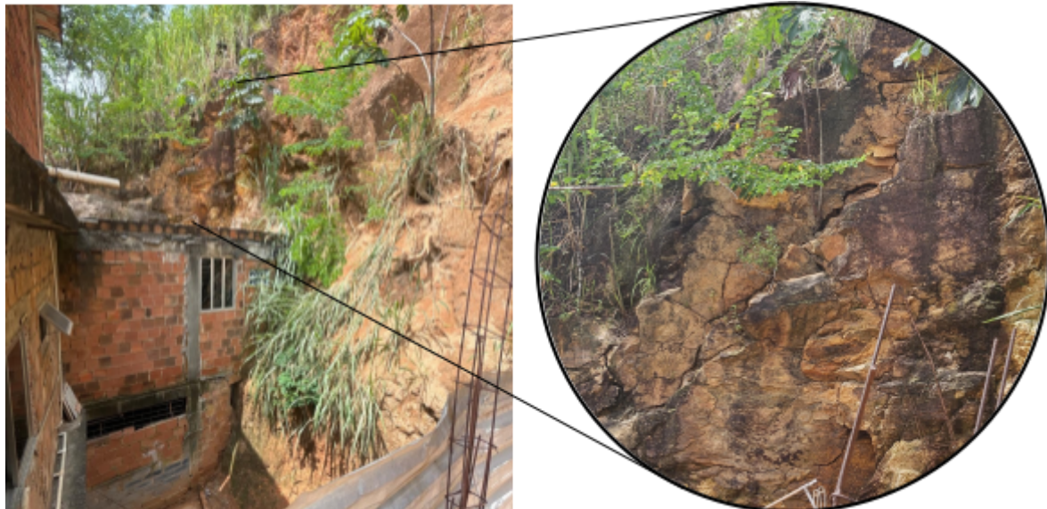
Figura 1. Imóvel de dois patamares, vizinho ao nº 275, com os fundos encaixados
