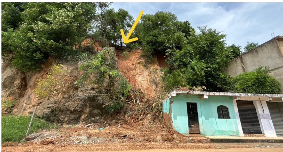
Figura 4. Vista frontal do evento com seta amarela apontando área de talude em ângulo negativo sobre rocha muito fraturada.
