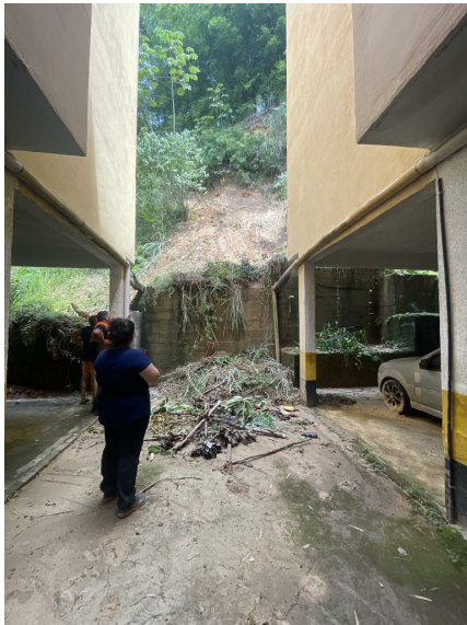
Figura 1: Deslizamento planar nos fundos do condomínio de número 471, atingindo o estacionamento.
