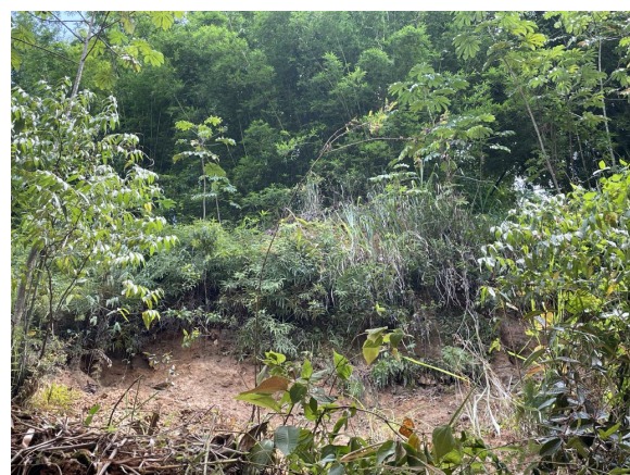
Figura 4: Vista frontal do deslizamento planar que ultrapassou o muro de alvenaria.
