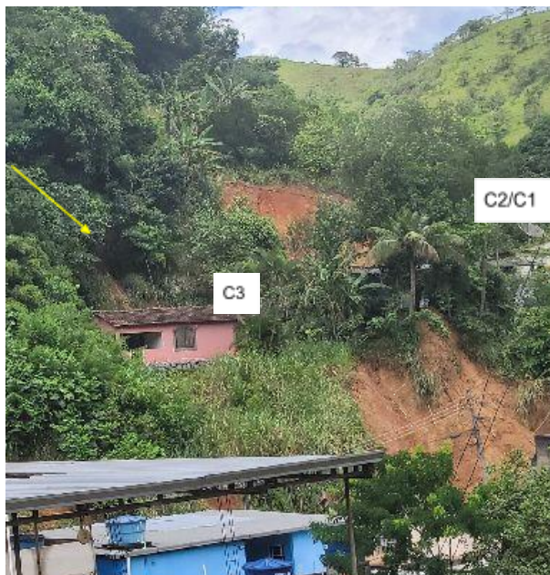
Figura 02: Deslizamento de grande porte a montante de C1 e C2, deslizamento menor a montante de C3 (seta amarela), e deslizamento a jusante.
