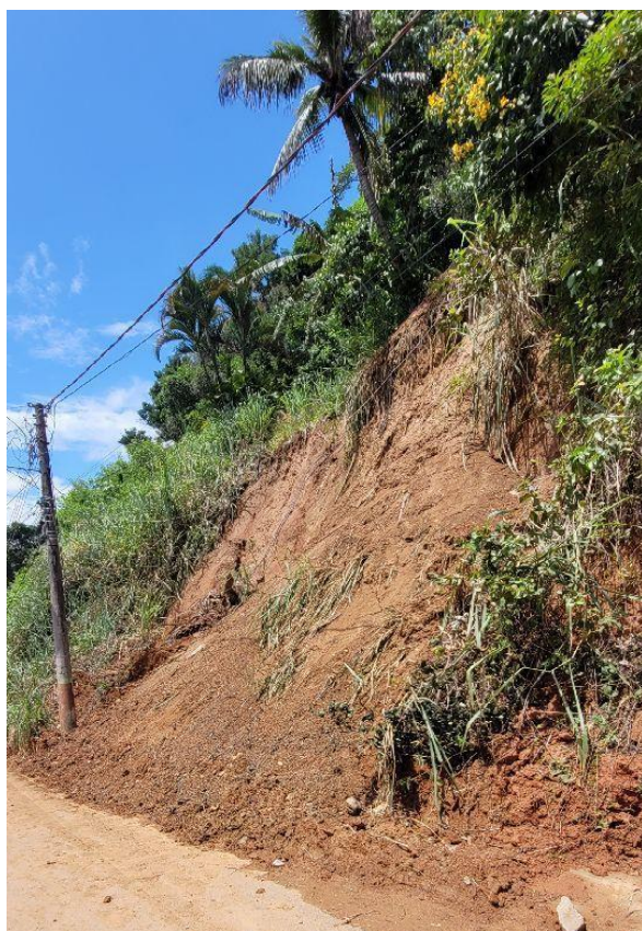
Figura 04: Deslizamento a jusante de C1 e C2, vista lateral do poste inclinado.
