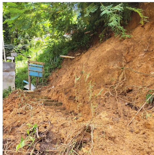
Figura 03: Deslizamento com soterramento parcial do caminho de acesso à casa nº 224.
