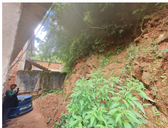
Figura 07: Talude aos fundos de C1.
