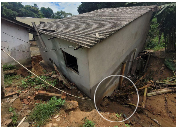
Figura 04: Tombamento de C2, vista a partir de C1, foco para obstrução do canal.
