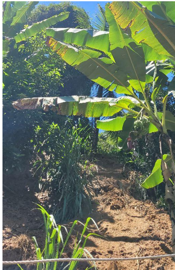
Figura 03: Deslizamento planar na base do imóvel C2.
