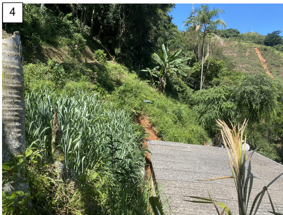
Figura 4: Casa localizada em um vale encaixado na rua Neivaldo, a uma distância nula do talude. É possível observar ao fundo uma cicatriz de deslizamento.
