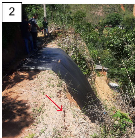
Figura 2 e 3: Em 2, deslizamento planar a montante da casa de nº 476 e degrau de abatimento (seta vermelha). Em 3, janela da casa de nº 476 mostrando desalinhamento com a parede.
