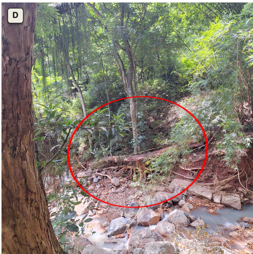
Figura D: Tronco de árvore de grande porte caído e outra erodida, tendo suas raízes expostas próximas ao córrego.
