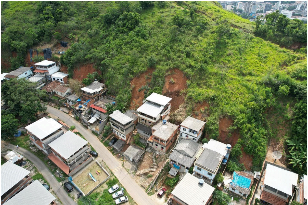
Figura 5: Cicatrizes de deslizamentos na rua Lucio Mansur Elias, trecho entre o nº 230 e o nº 98.
