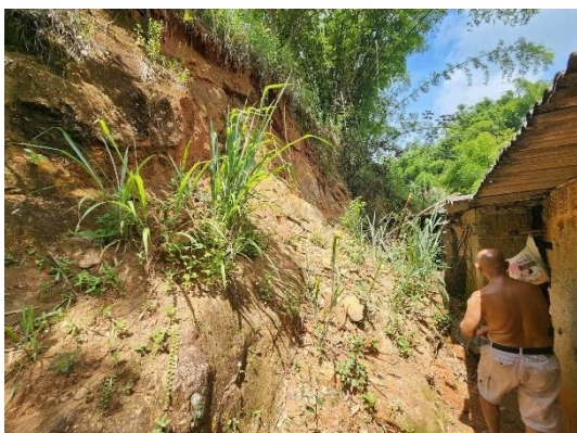
Figura 9: Ocorrência F, deslizamento aos fundos do N° 294
