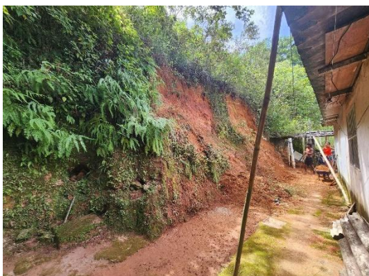
Figura 7: Ocorrência D, deslizamento em talude aos fundos do N° 269
