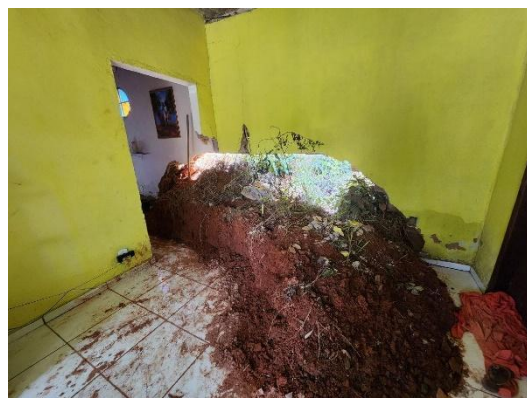
Figura 4: Atingimento da ocorrência B causando danos a residência.
