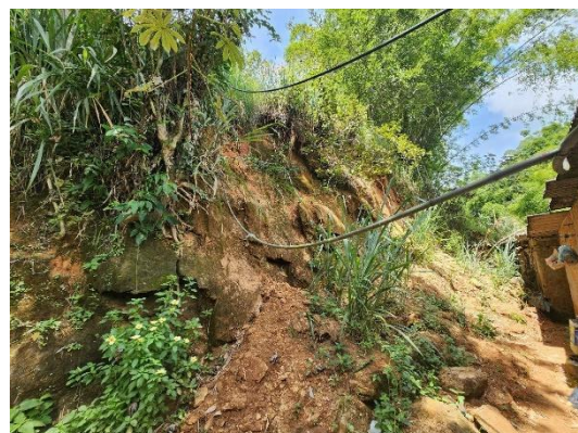
Figura 10: Porções de camadas de rocha expostas após o deslizamento, junto com raízes de árvores
