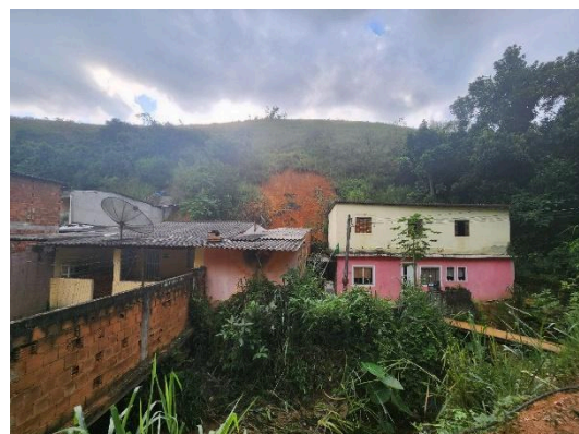
Figura 6: Ocorrência E, deslizamento que atingiu as casas de nº 70 e nº 100
