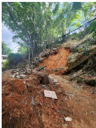
Figura 1: Ocorrência A, deslizamento que interditou a entrada da Rua Osório de Freitas e destruiu o acesso para as casas da Ladeira Manoel F. Neto
