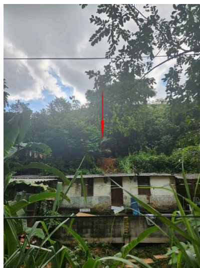
Figura 5: Ocorrência D, deslizamento que atingiu os fundos da casa na R. Osório de Freitas onde não foi possível ter maior acesso.
