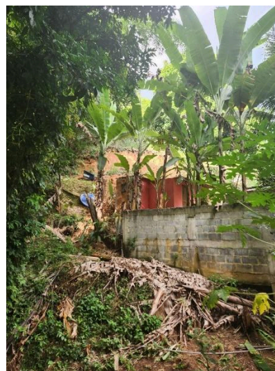
Figura 2: Ocorrência B, deslizamento aos fundos da casa nº 219
