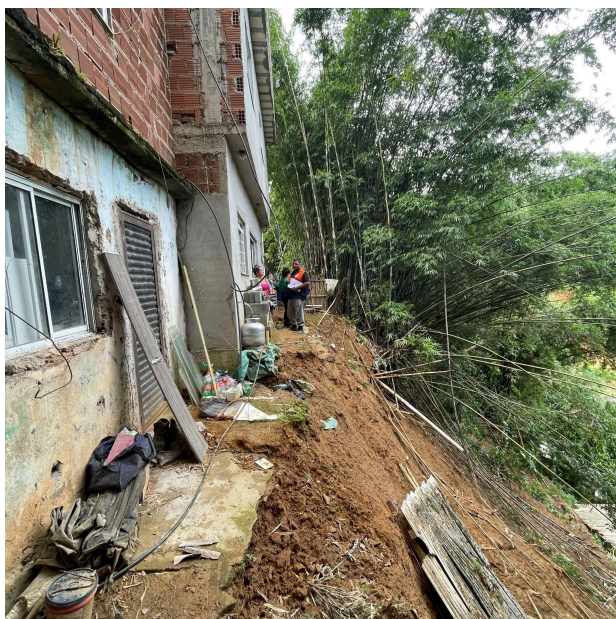
Figuras 1 e 2: Deslizamento do Tipo Planar aos fundos das residências 901 e 901 Casa 1 na Rua das Margaridas em direção a Rua Prefeito Henrique Borges
