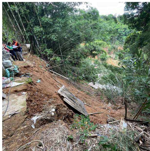
Figuras 1 e 2: Deslizamento do Tipo Planar aos fundos das residências 901 e 901 Casa 1 na Rua das Margaridas em direção a Rua Prefeito Henrique Borges
