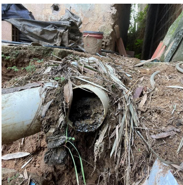
Figuras 8 e 9: Tubulação de esgoto avariada
