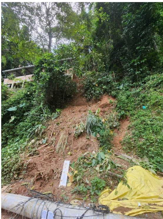
Figuras 5 e 6: Material mobilizado interditando a via depositado a jusante da Rua Prefeito Henrique Borges
