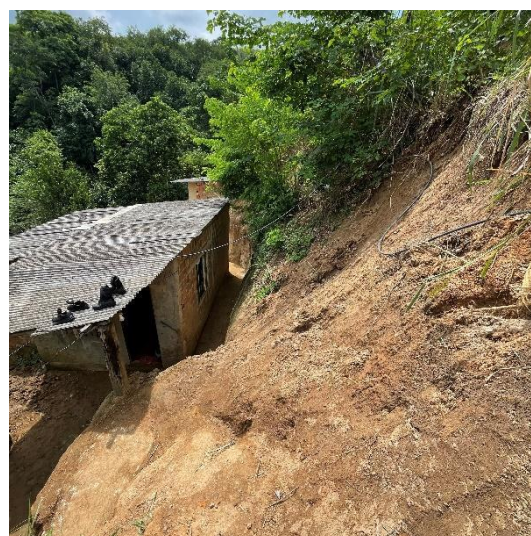
Figura 8: Distância das edificações do talude a montante, que apresenta feições de processo erosivo ativo
