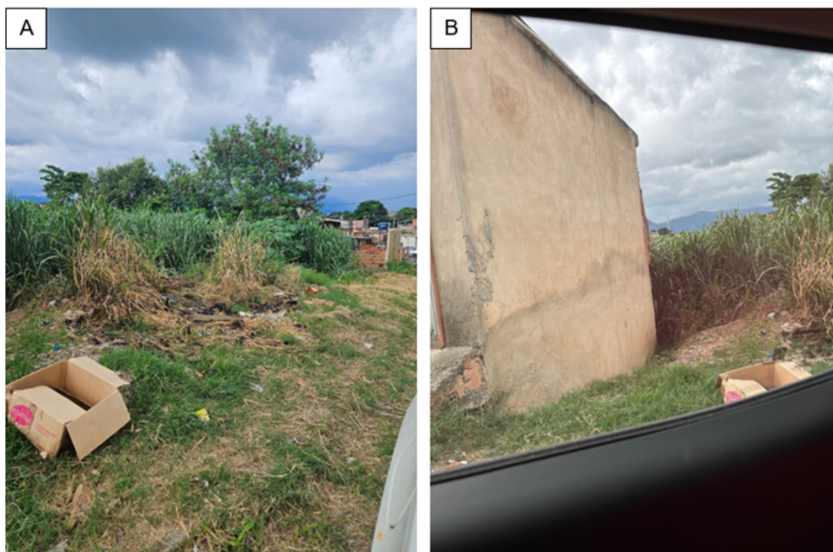
Figura 03: A) Crista do talude sob o qual houve deslizamento na base, com deposição de RSU e indícios de queima de material; B) Imóvel assente no corpo da vertente, próximo à crista do talude, com perda de material e processos erosivos observados no talude verticalizado na lateral da edificação.
