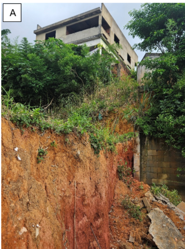
Figura 01: A) Cicatriz do deslizamento ocorrido no talude verticalizado localizado na lateral do terreno, demonstrando área de alcance do material mobilizado sob ruínas de muro limítrofe colapsado; B) Área de atingimento do imóvel pelo deslizamento do talude verticalizado, que sucedeu em desabamento de toda a parte posterior da edificação.
