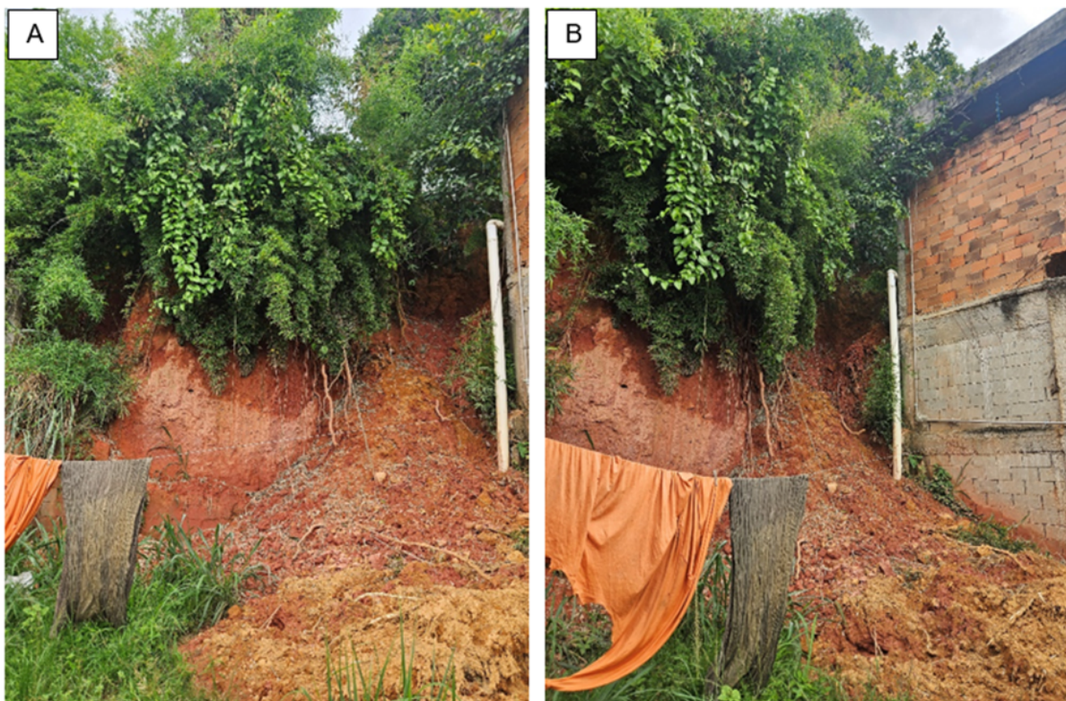
Figura 02: A) Cicatriz ocorrida na encosta localizada nos fundos do terreno, demonstrando área de alcance do material mobilizado e, camada de acumulação maior de 1 m; B) Visada lateral da cicatriz de deslizamento demonstrando deposição de material aos fundos da edificação.
