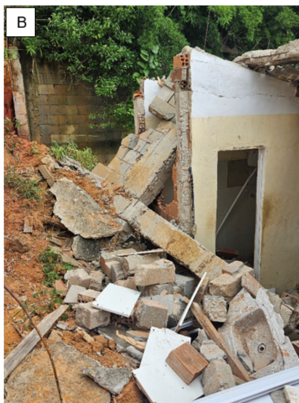
Figura 01: A) Cicatriz do deslizamento ocorrido no talude verticalizado localizado na lateral do terreno, demonstrando área de alcance do material mobilizado sob ruínas de muro limítrofe colapsado; B) Área de atingimento do imóvel pelo deslizamento do talude verticalizado, que sucedeu em desabamento de toda a parte posterior da edificação.
