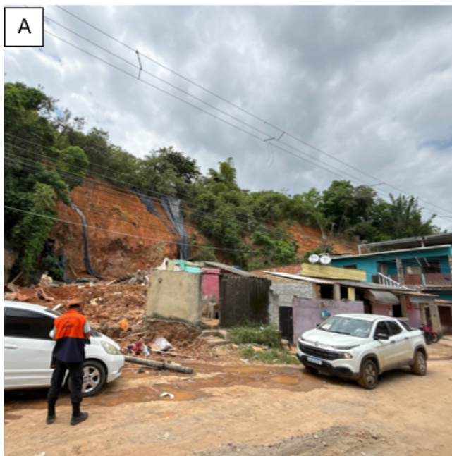
Figura 02: A) Área de maior atingimento do material mobilizado, com imóveis apresentando colapso total (nº 15) e parcial. B) Colapso parcial da área dos fundos de imóvel e, presença de material instável na porção superior da encosta.
